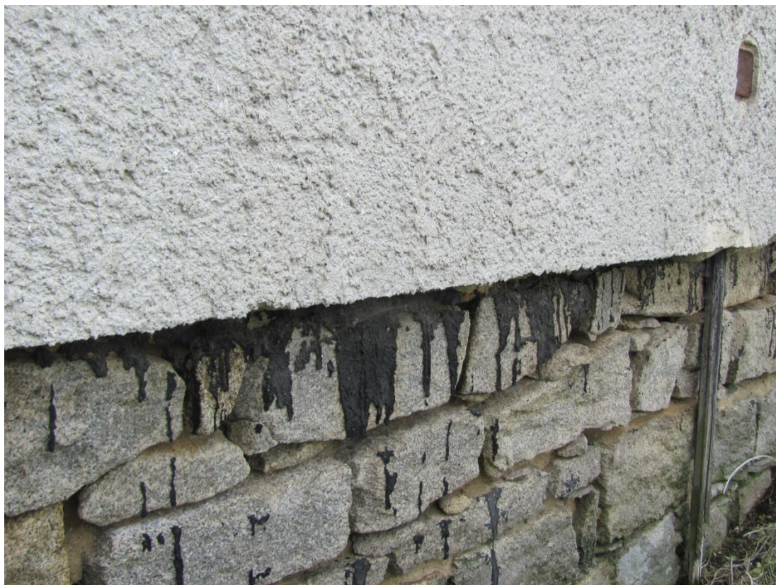
Foto č. 15 – pohled na základové zdivo s viditelnými známkami použití hydroizolace (zdroj: vlastní fotografie)
