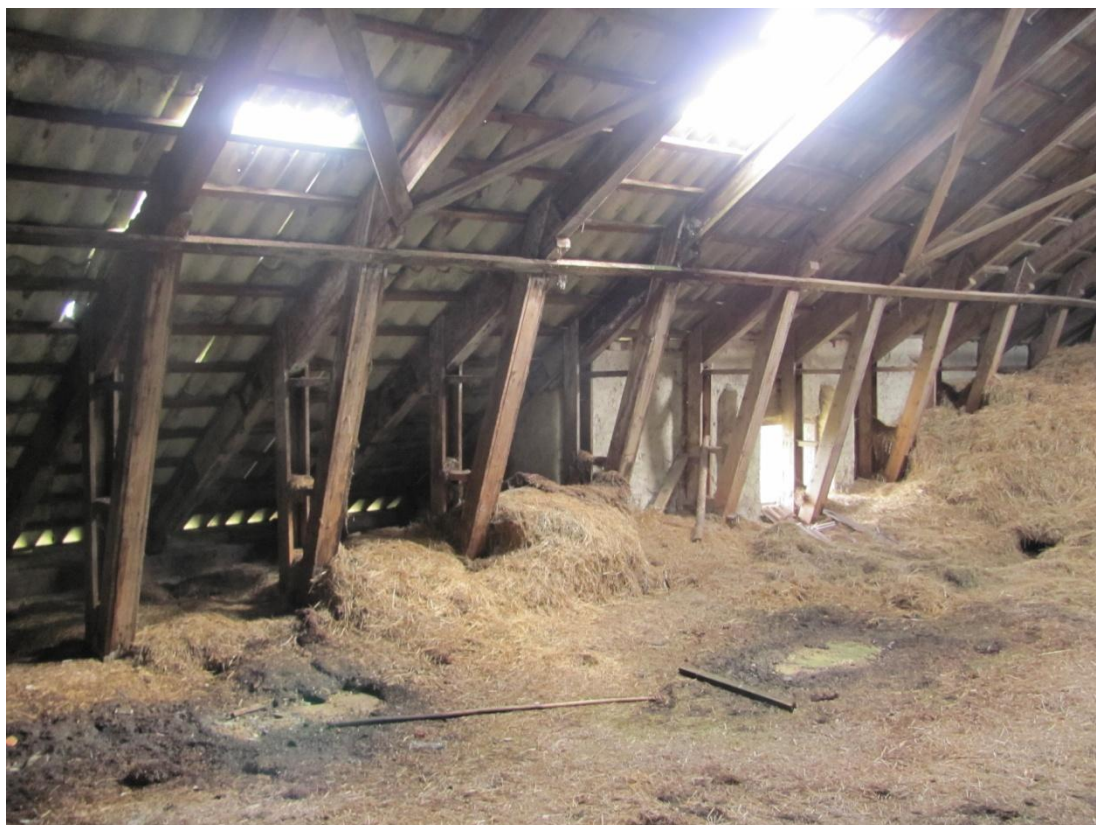
Foto č. 22 – pohled na část krovu, kde chybí krytina (zdroj: vlastní fotografie)
