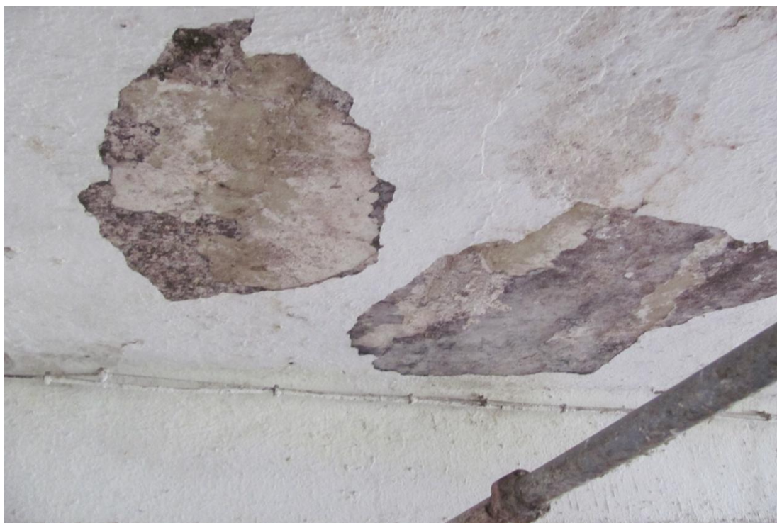
Foto č. 19 – pohled na vlhkostní mapy, které vznikly vlivem vlhkosti (zdroj: vlastní fotografie)
