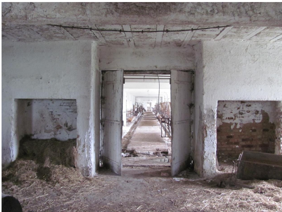
Foto č. 1 – otvory, do kterých se shazovala sláma nebo suchá píce (zdroj: vlastní fotografie)
