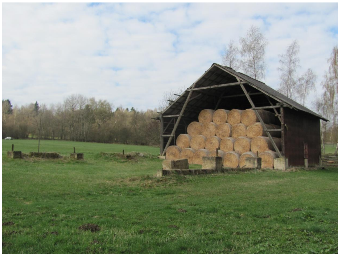
Foto č. 8 – pohled na pozůstatky skladovací haly (zdroj: vlastní fotografie)
