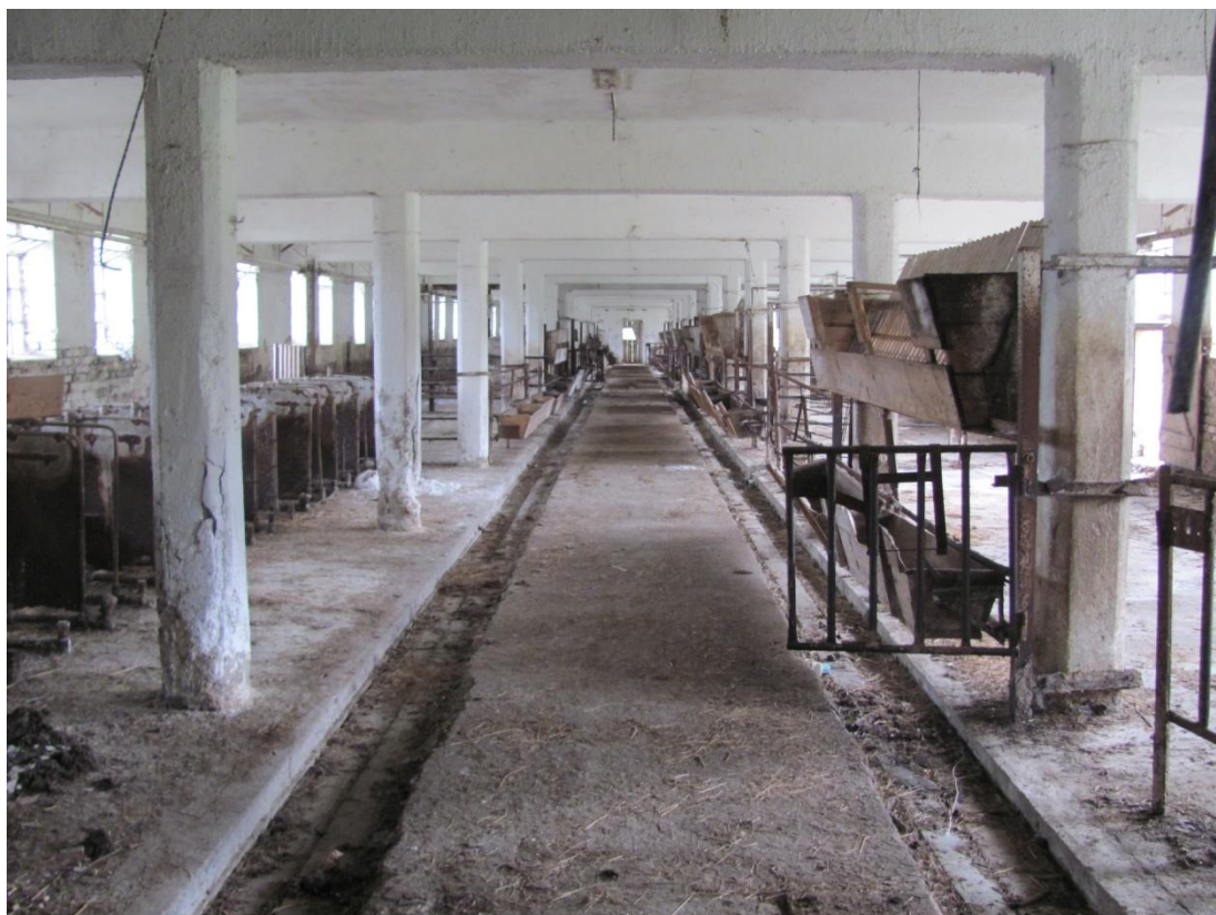
Foto č. 10 – pohled na středovou chodbu stáje (zdroj: vlastní fotografie)
