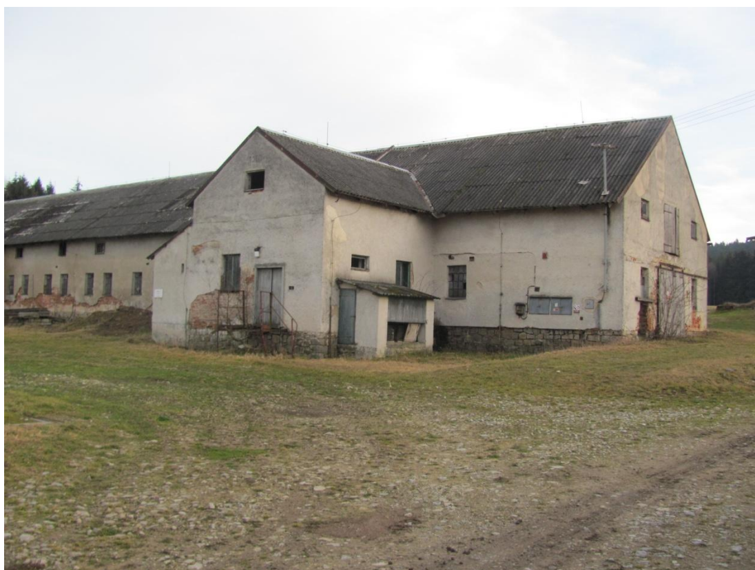
Foto č. 3 – severozápadní pohled na stávající objekt (zdroj: vlastní fotografie)
