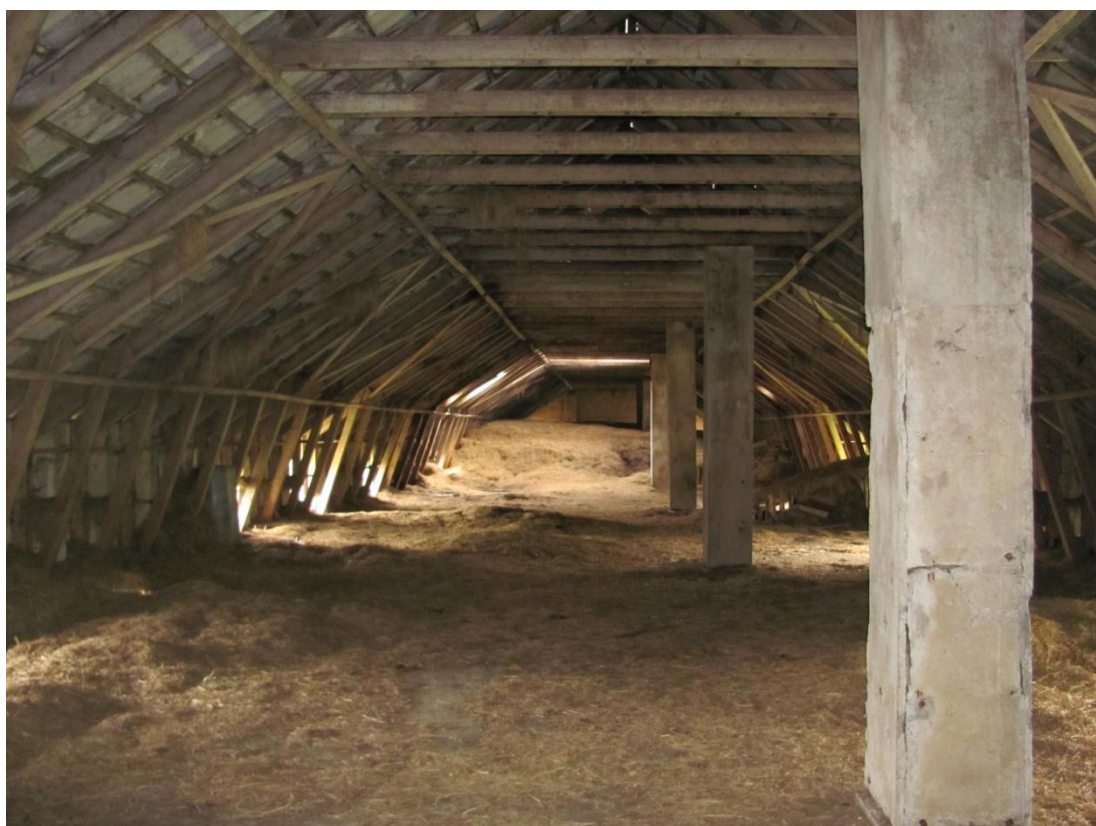
Foto č. 11 – pohled do půdního prostoru (zdroj: vlastní fotografie)
