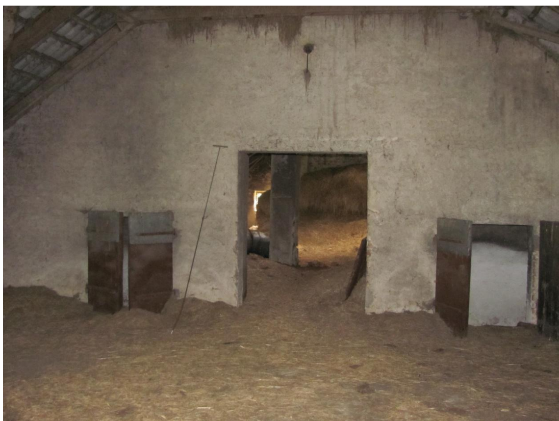
Foto č. 2 – otvory, do kterých se z půdy shazovala sláma nebo suchá píce (zdroj: vlastní fotografie)
