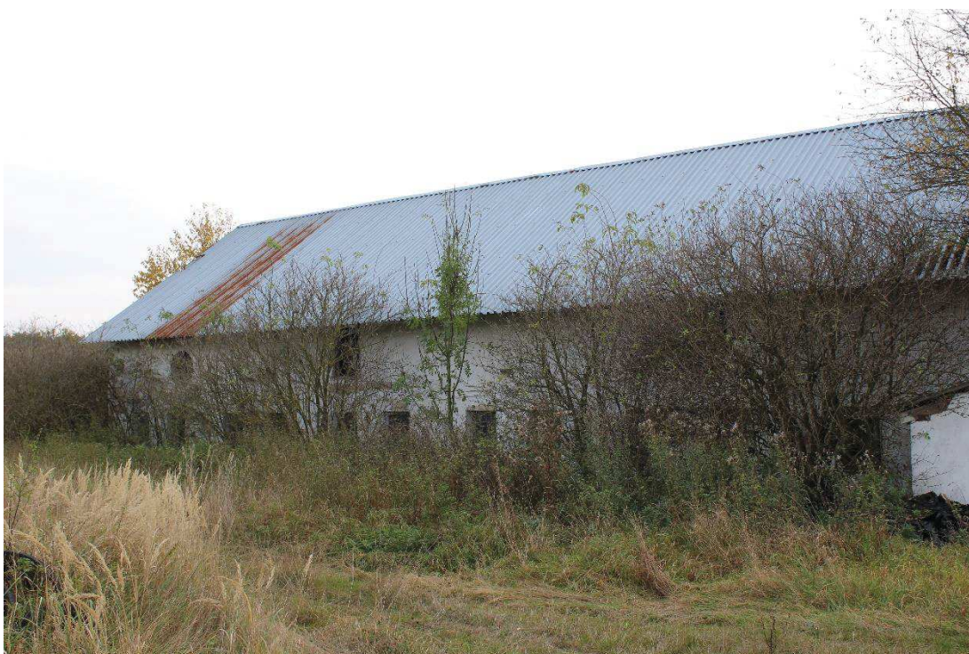
Obrázek 2 Severní pohled – jižní část objektu (Zdroj: vlastní šetření)
