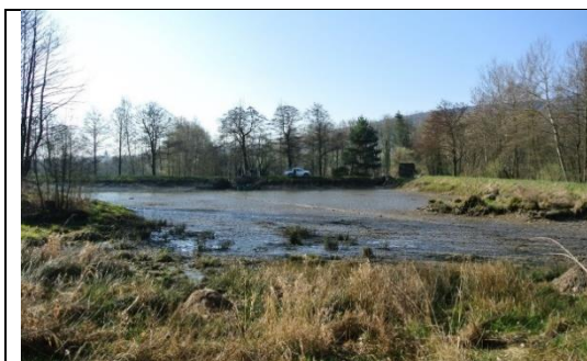
Foto 15.: Vypuštěný rybník pohled od severu 1.4.2017 (LP)
