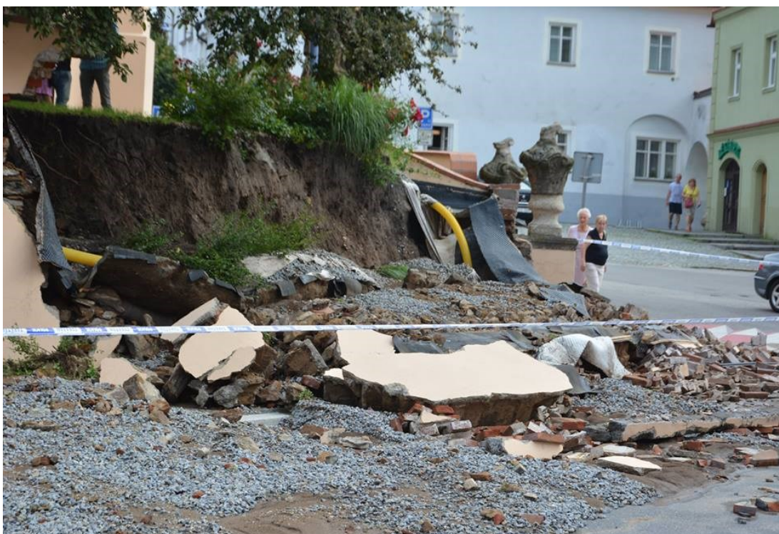
Obrázek č. 26: Následky po přívalových povodních, červenec 2016, zdroj: archiv Městský úřad Týn nad Vltavou
