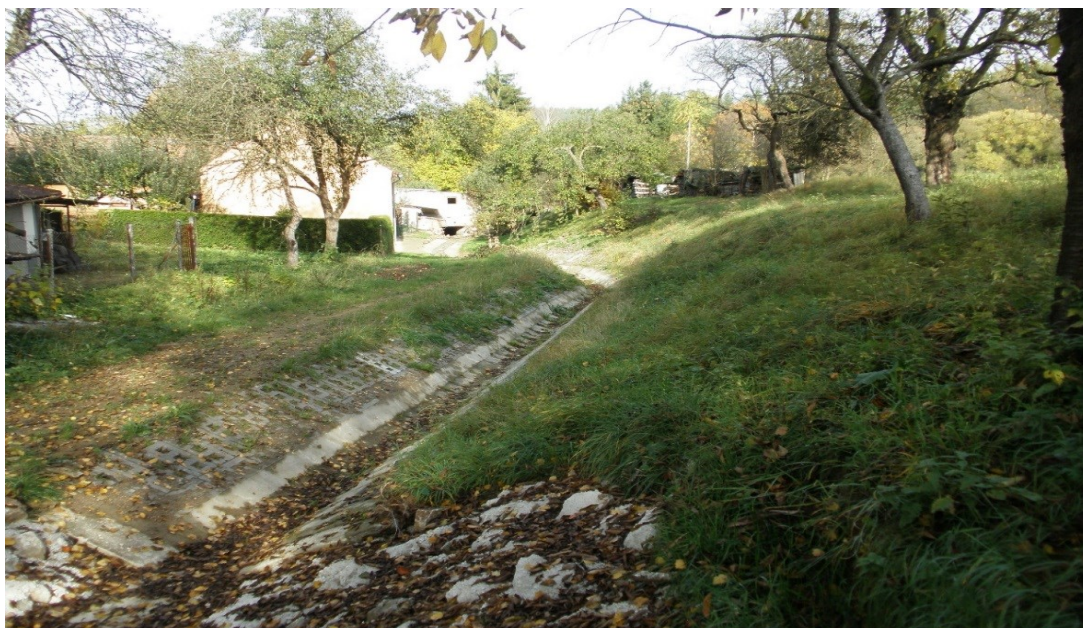
Obrázek č. 20: Odvodňovací kanál pod propustkem. Foto Koloděje – Cihelny, říjen 2016, zdroj: vlastní
