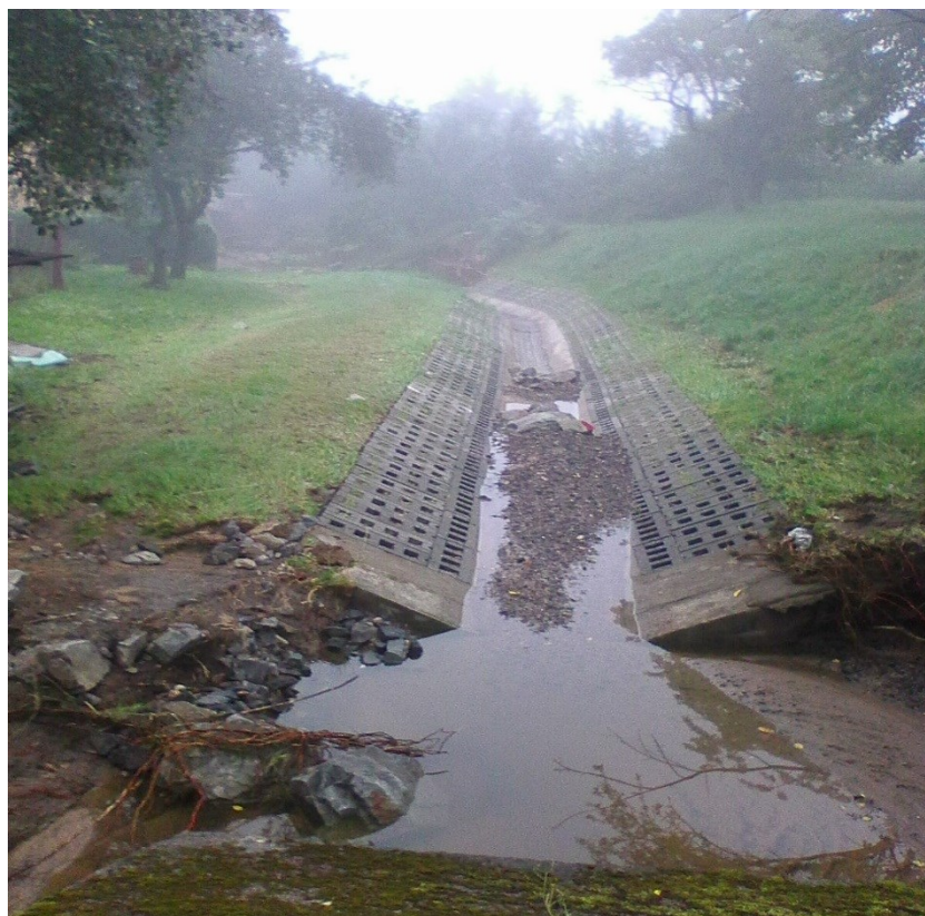
Obrázek č. 23 a č. 24: Propustek po přivalových povodních, červenec 2016, zdroj: archiv Městský úřad Týn nad Vltavou
