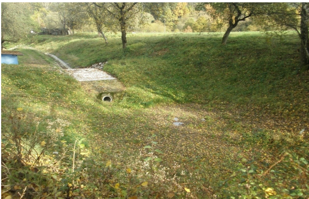
Obrázek č. 21: Pohled na propustek. Foto Koloděje – Cihelny, říjen 2016, zdroj: vlastní
