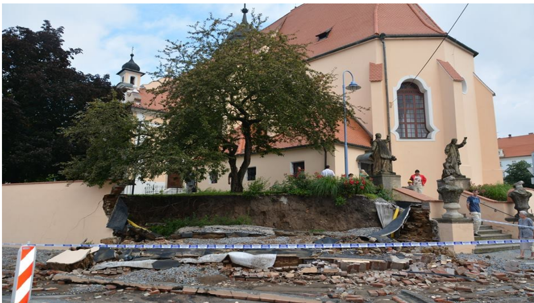
Obrázek č. 25: Následky po přívalových povodních, červenec 2016, zdroj: archiv Městský úřad Týn nad Vltavou
