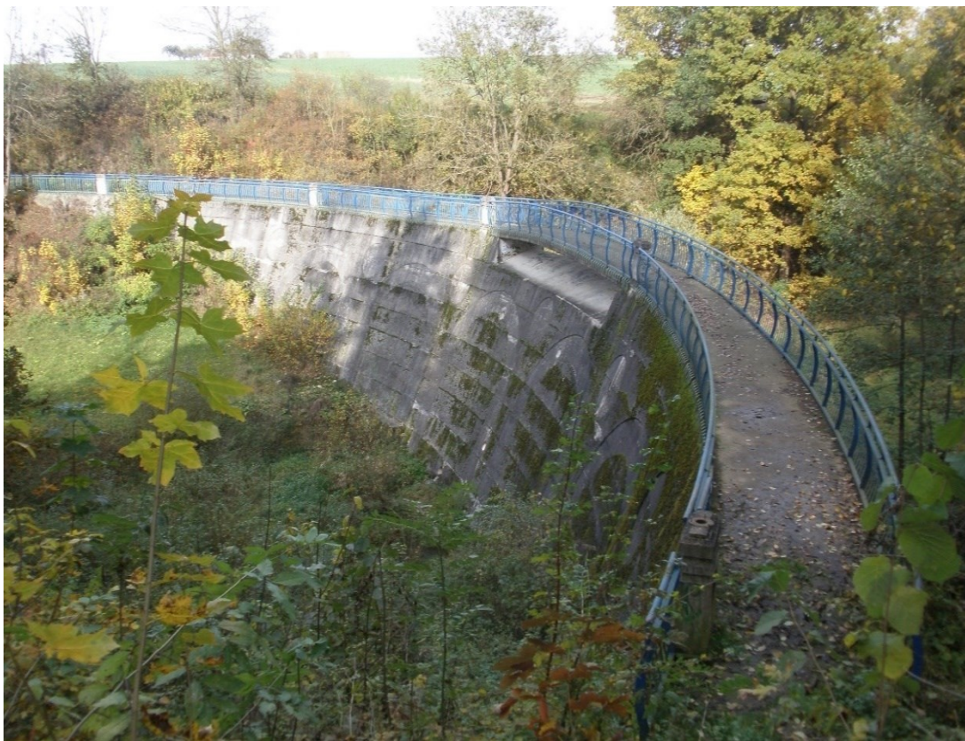
Obrázek č. 2: Foto retenční nádrž Hlinky, říjen 2016, zdroj: vlastní
