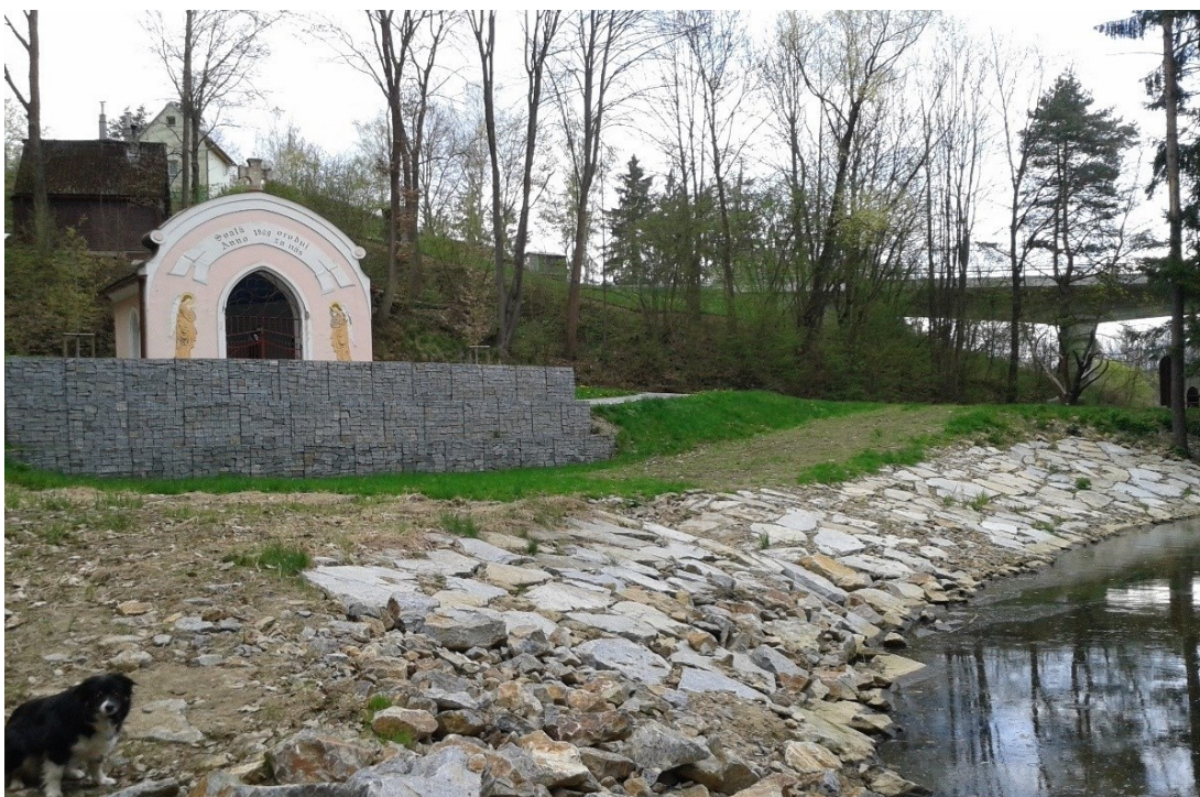
Obrázek č. 14: Foto současného stavu po realizaci opevnění břehů, březen 2017, zdroj: vlastní
