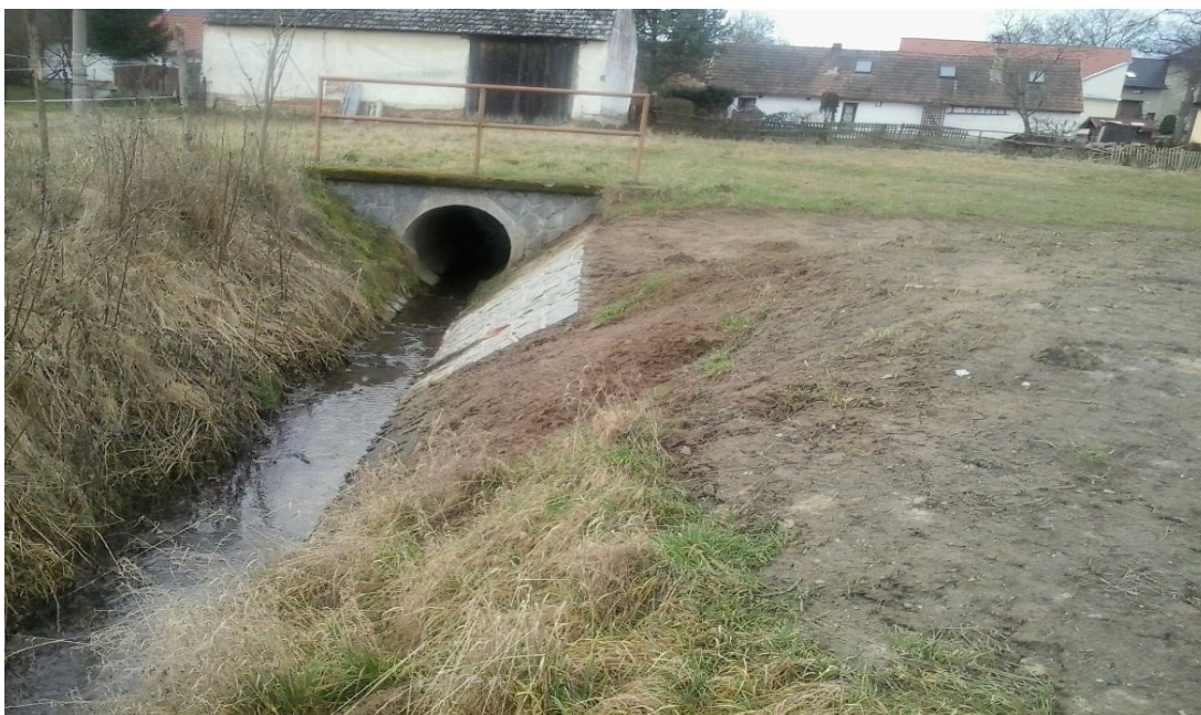
Obrázek č. 15: Foto z realizace průlehu a opevnění toku ve Slavěticích, březen 2016, zdroj: vlastní
