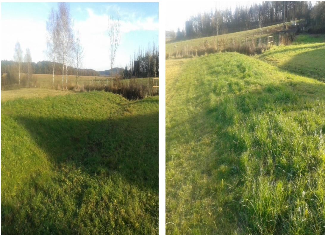
Obrázek č. 16: Foto po realizaci zasakovacího průlehu ve Slaveticích, říjen 2016, zdroj: vlastní
