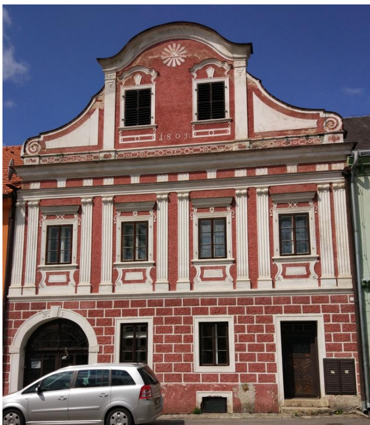
Obr. č. 3. - dům č. p. 5.
