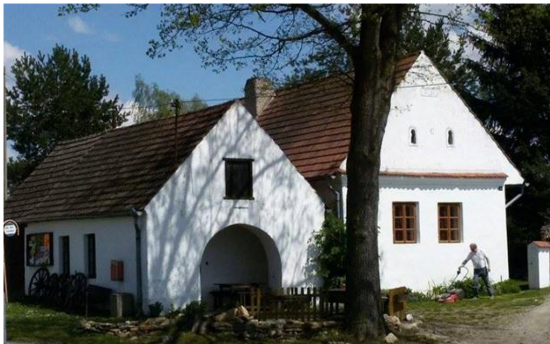
Obr. č. 8. – Usedlost č. p. 1.
