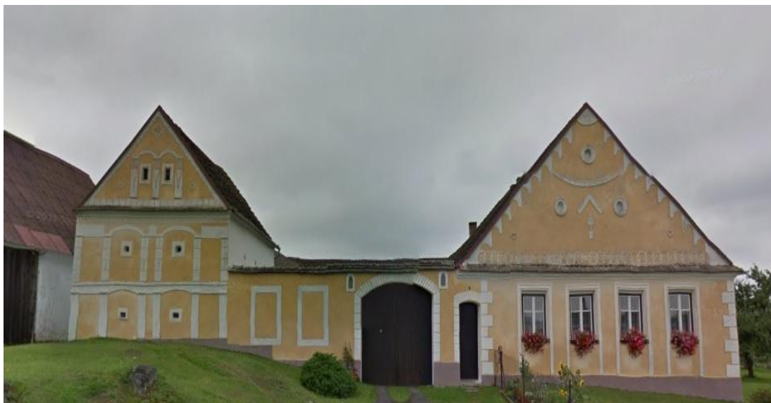
Obr. č. 10. – Usedlost č. p. 4.
