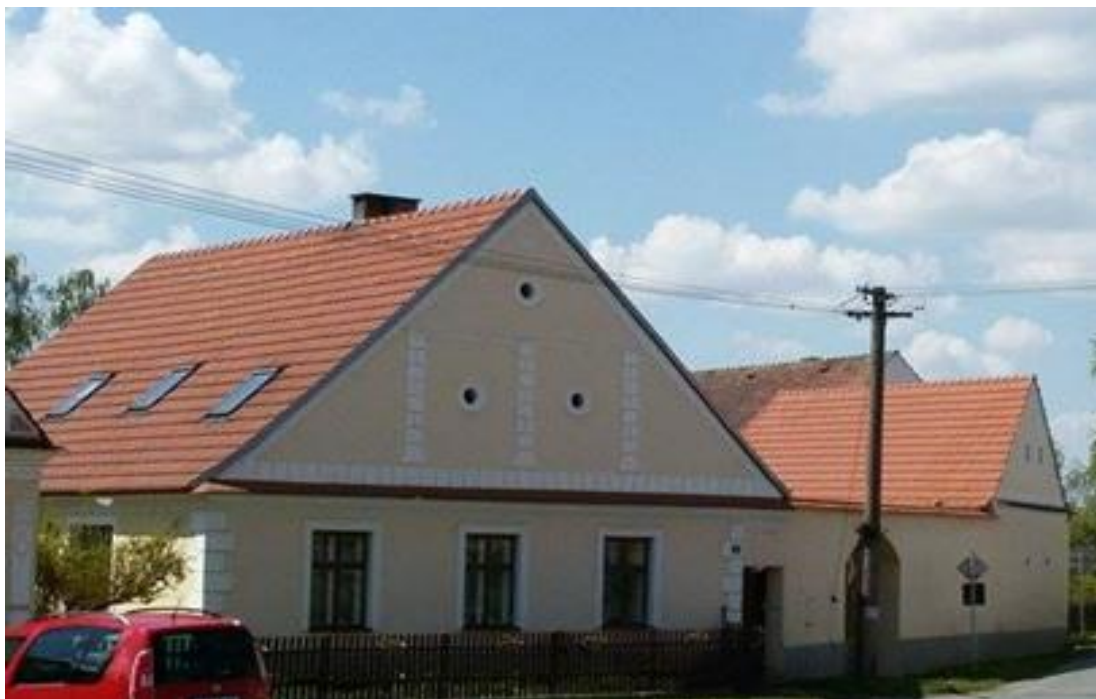
Obr. č. 12. – Usedlost č. p. 6.
