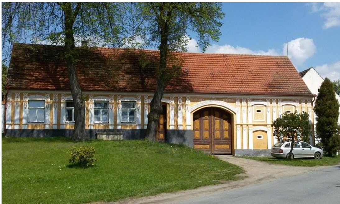
Obr. č. 14. – Usedlost č. p. 9.
