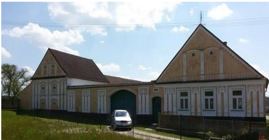
Obr. č. 9. – Usedlost č. p. 3.
