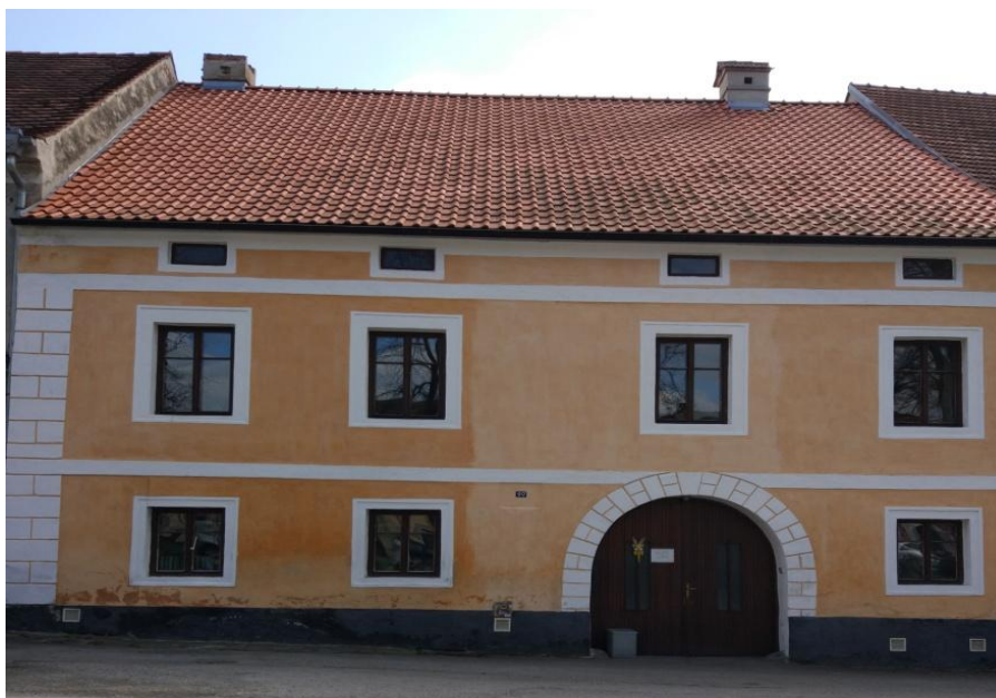
Obr. č. 4. - dům č. p. 29.
