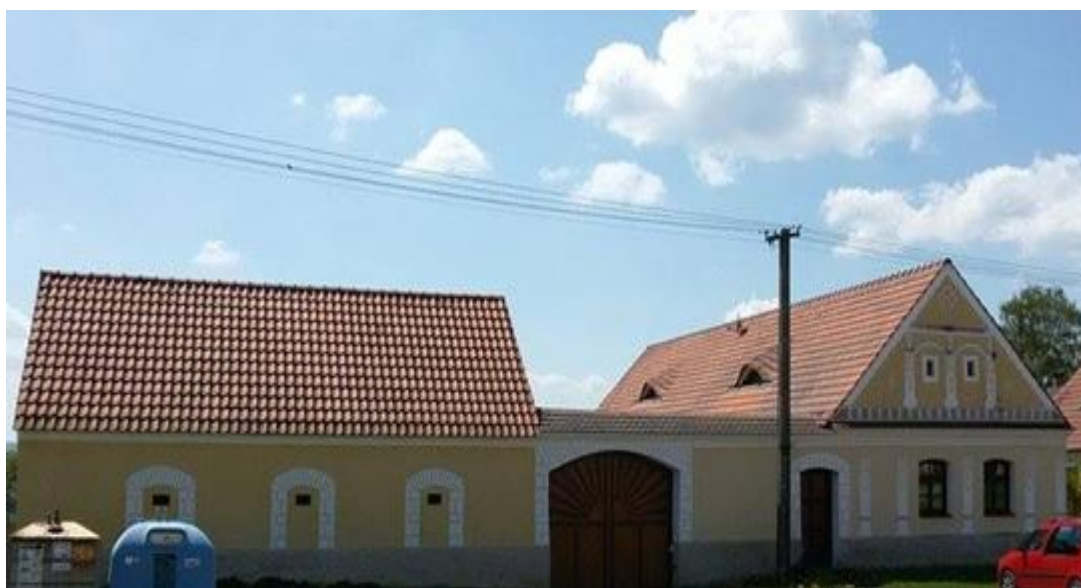
Obr. č. 11. – Usedlost č. p. 5.
