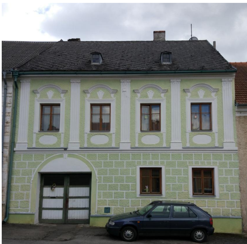
Obr. č. 5. - dům č. p. 60.
