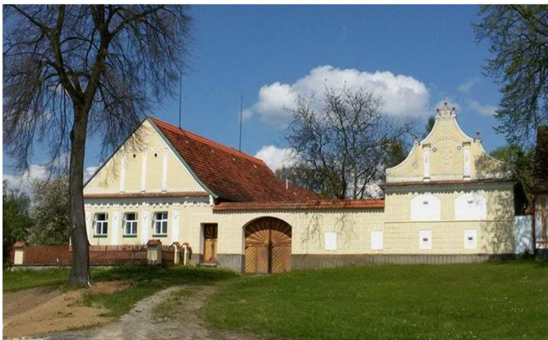
Obr. č. 13. – Usedlost č. p. 8.
