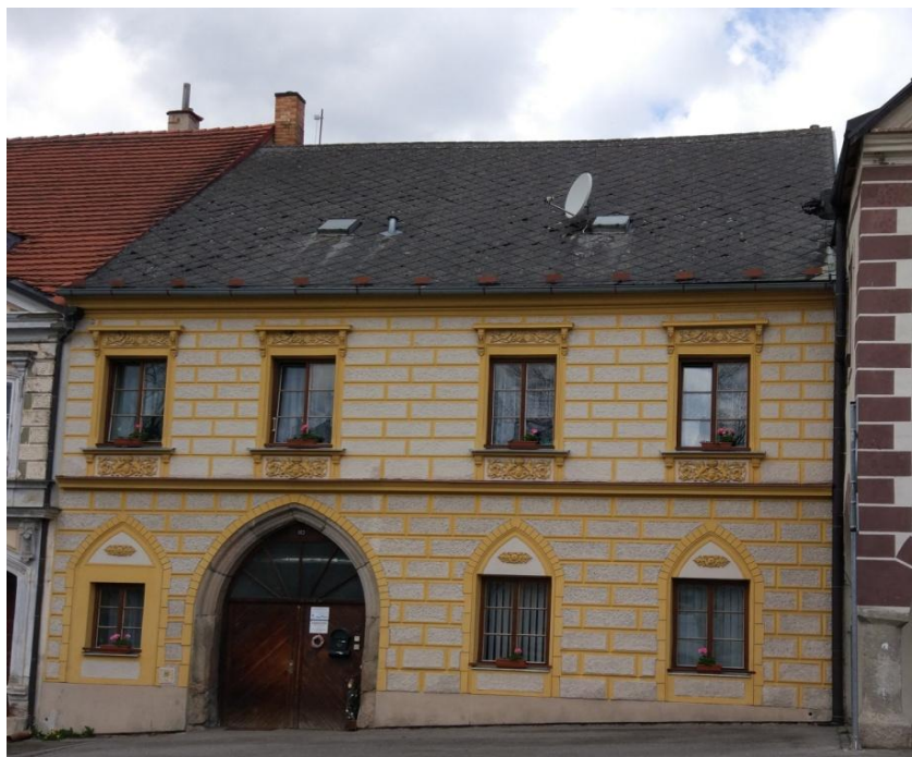
Obr. č. 6. - dům č. p. 123.
