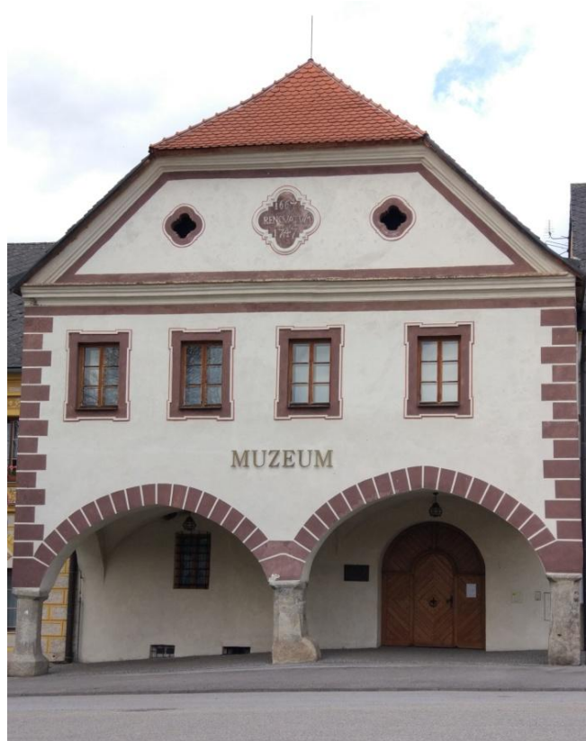
Obr. č. 7. - dům č. p. 124.
