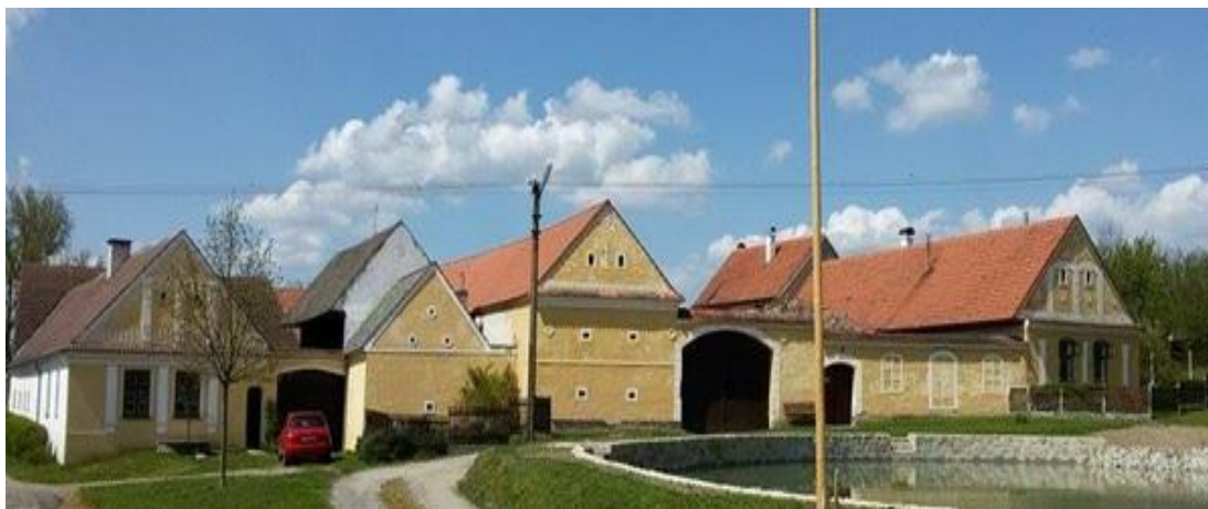
Obr. č. 15. – Usedlosti č. p. 7. a 11.
