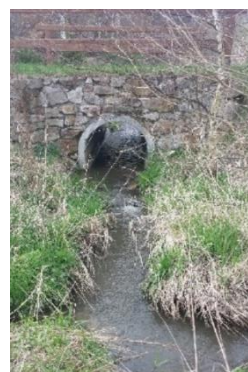
Obr. č. 10: Propustek
