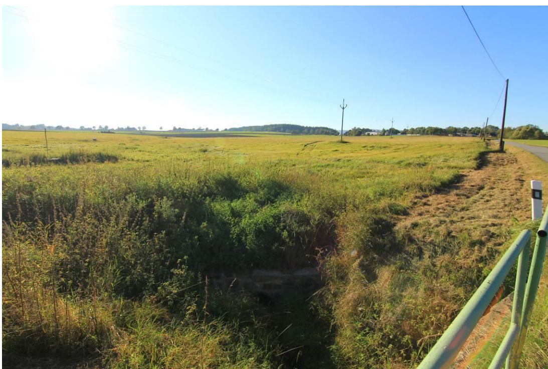
Fotografie. č.6 – Ústí odvodňovacího systému do levého přítoku na komunikaci 1581 III třídy 120 metrů před obcí Dobečov, zdroj: vlastní
