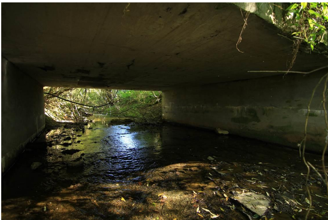
Fotografie. č.1 – Průtočný profil mostu na HPC 1, zdroj: vlastní
