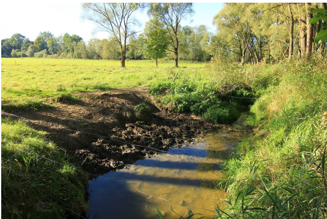
Fotografie. č.8– Elektrický ohradník přes koryto toku a napajedlo dobytku, zdroj: vlastní
