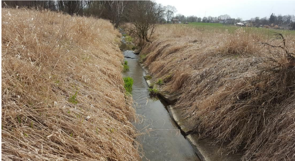
Fotografie. č.13 – koryto v úseku 3 s opevněným dnem a břehy, zdroj: vlastní
