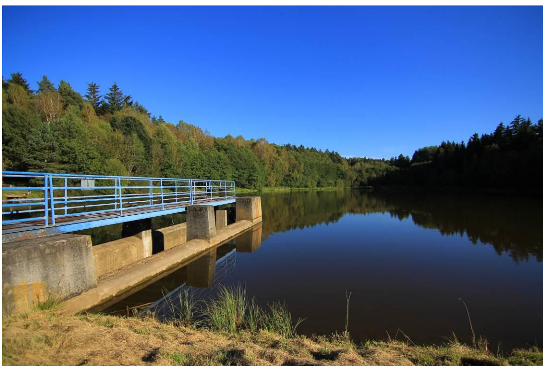
Fotografie. č.27 – Bezpečnostní přeliv s výpustným zařízením na Dobečovské nádrži, zdroj: vlastní
