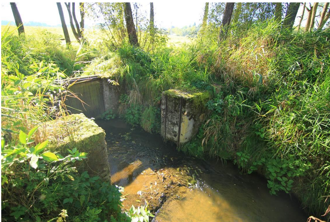
Fotografie. č.9 – Propustek z potoku do Nového rybníku, zdroj: vlastní
