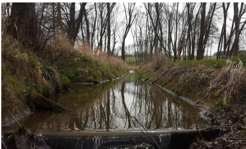
Fotografie č.10 – opevněné koryto v úseku 1, zdroj: vlastní
