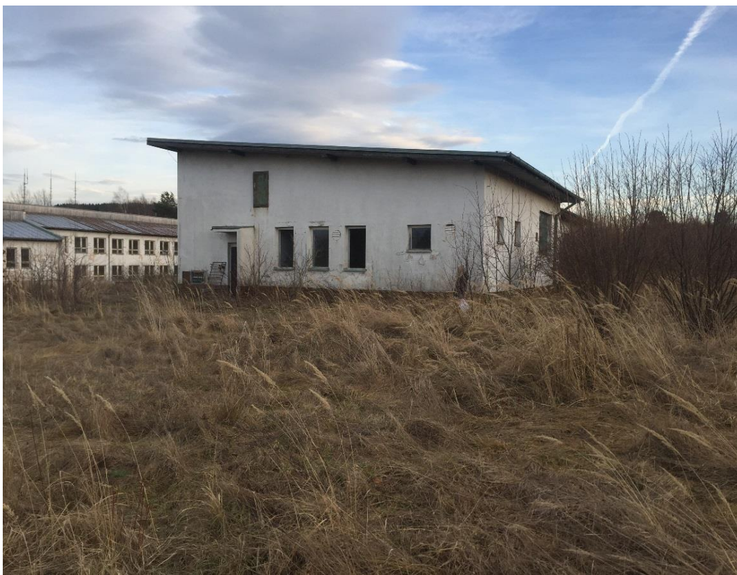
Příloha č. 10. bývalé garáž, boční strana, Šejby, zdroj vlastní.
