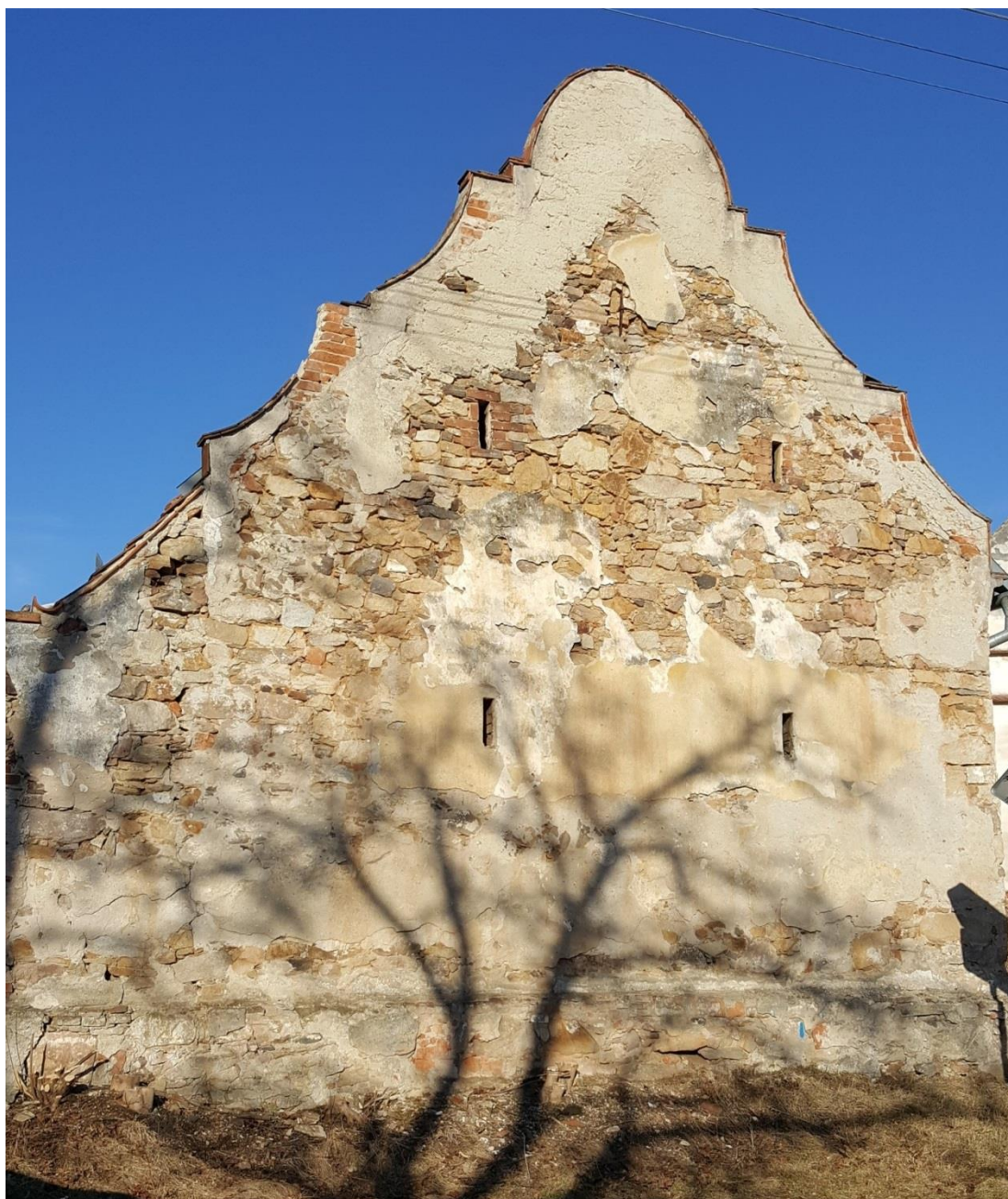
Příloha č. 4. sýpka pohled ze silnice, Štěkeň, zdroj vlastní.
