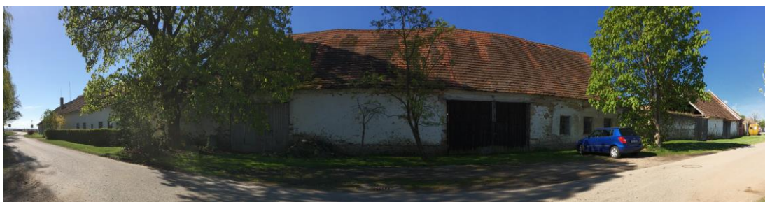
Obr. č.30 Řada hospodářských stavení při bývalé záhumenní cestě (Zdroj: autor)
