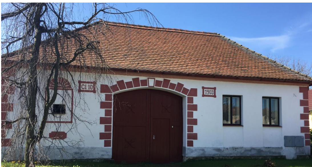
Obr. č. 34 Usedlost čp. 10 v obci Vlhavy (Zdroj: autor)
