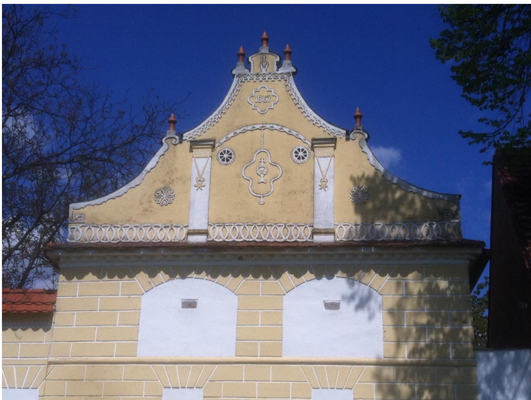
Obr. č. 40 Zdobený štít stavení v čp. 8 v obci Záluží (Zdroj: autor)
