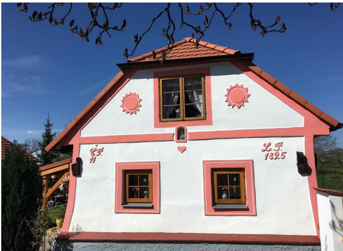
Obr. č. 38 Roubené stavení „v kožichu“ z roku 1825 v obci Malé Chrášťany (Zdroj: autor)
