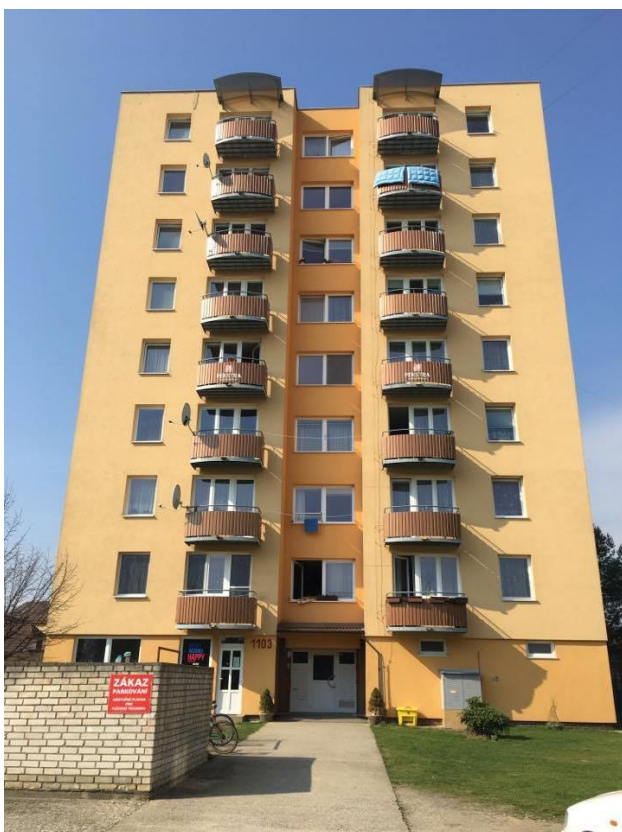
Obr. č. 7: Panelový dům č. p. 1103 („Foto: Josef Neužil“)
