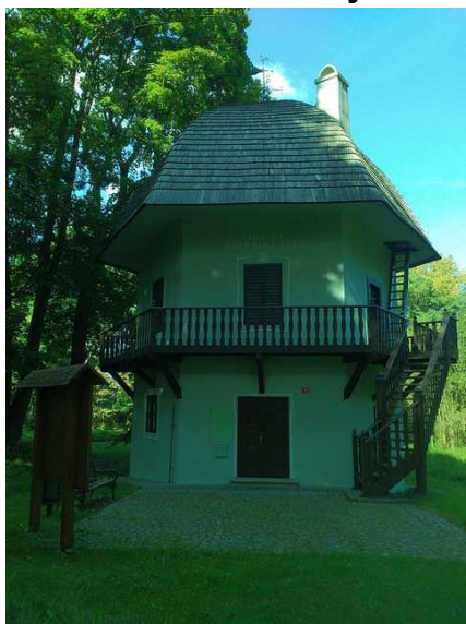
Hříbek - severní pohled
