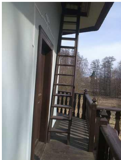
Přístup do podkroví
