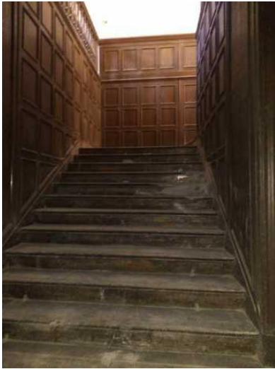
Schodiště do 2.NP
