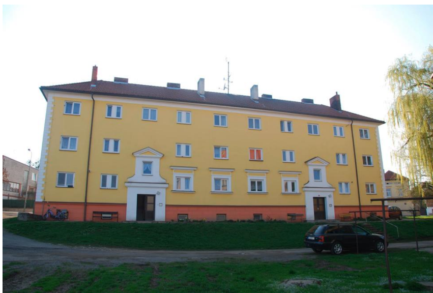
Obrázek č. 18: bytový dům čp. 597 a 598, východní pohled
