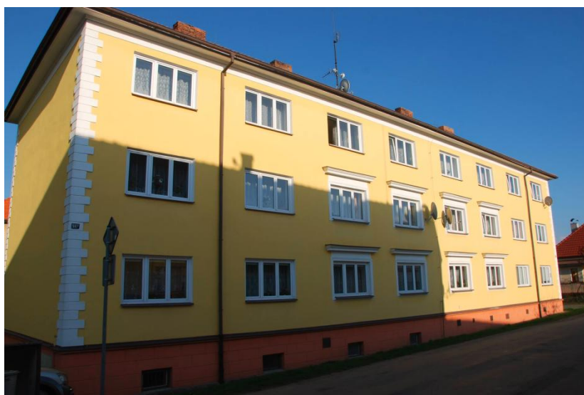
Obrázek č. 19: bytový dům čp. 597 a 598, západní pohled
