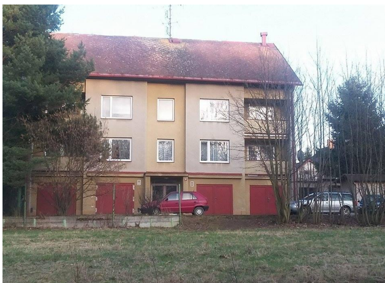
Obrázek č. 7: Bytový dům čp. 269, východní pohled
