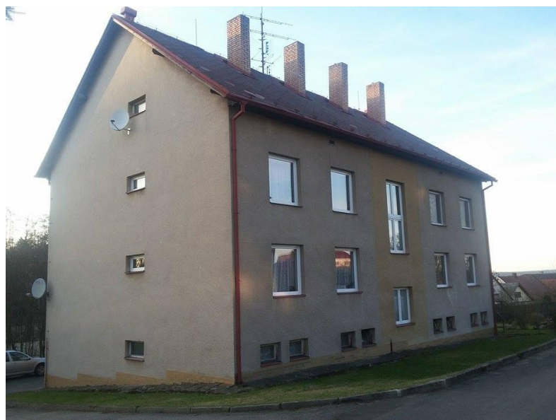
Obrázek č. 8: Bytový dům čp. 269, západní pohled
