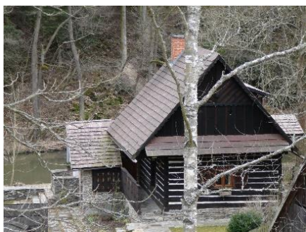
Obr. č. 17: Bývalá sýpka
