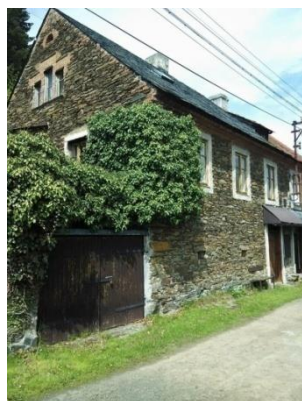
Obr. č. 25: Městský dům s verandami (č. p. 67)
