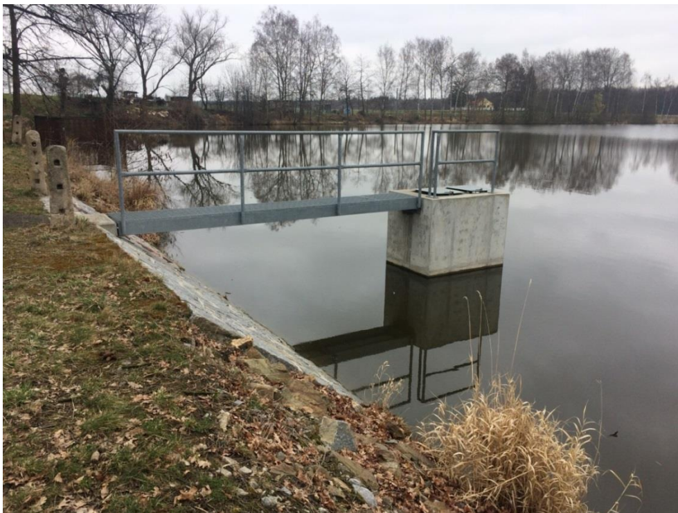
Foto č. 1: Nádrž č. 1 (Ovčácký rybník) - celkový pohled na nádrž a jeho vypouštěcí zařízení
