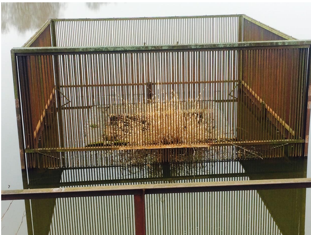
Foto č. 2: Betonový propustek obdélníkového průřezu (Benešovy rámy) na Ovčáckém rybníku
