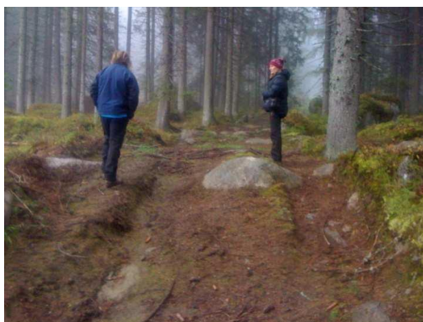
Obr. č. 40: Linka 2 roky stará po LKT, patrné hluboké koleje proti vrstevnici, lokalita Modrava (zdroj: Svoboda, Gallas a kol., 2012).
