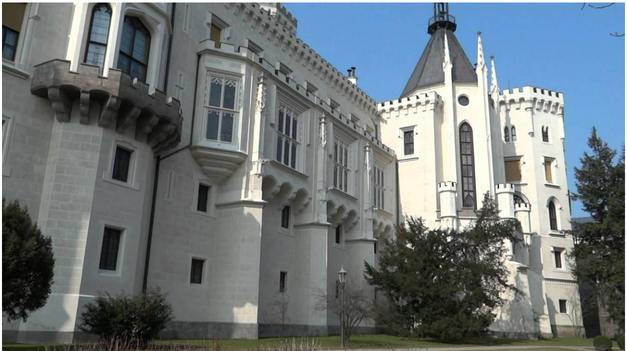
Obr. II/8: Zámecká kaple s galerií
