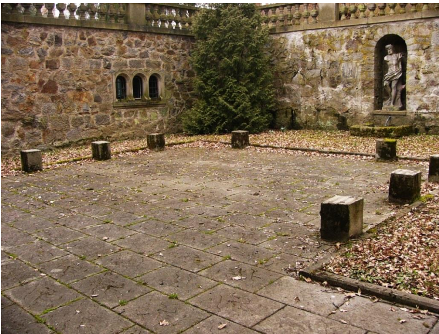
Obr. 43- Kamenný dvorek obestavěný kamennou zdí, před jižní fasádou, současný stav 2016.
