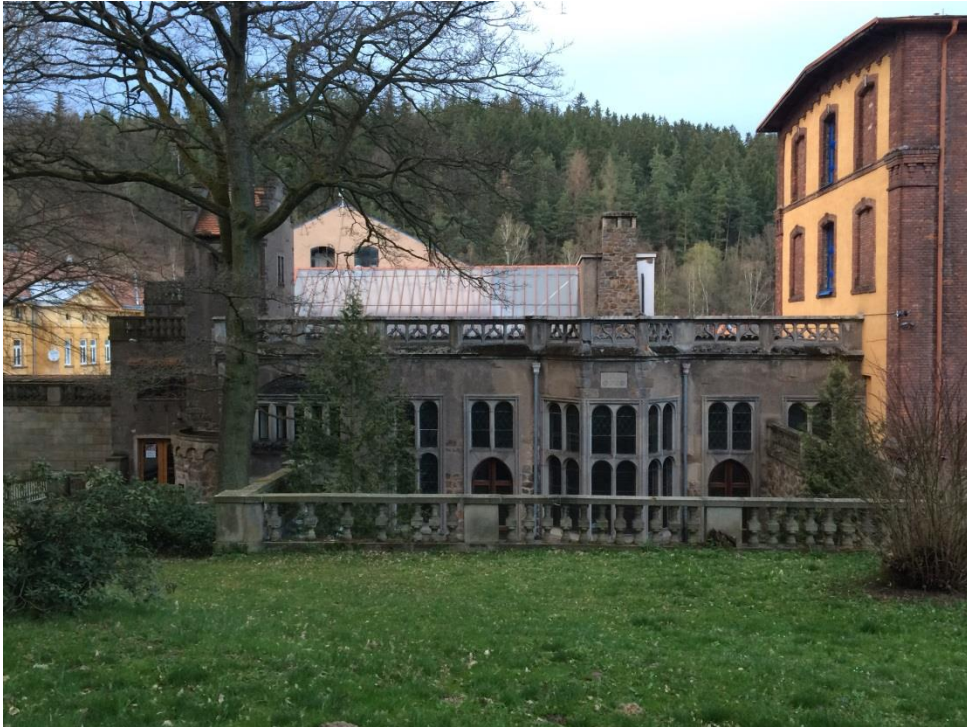
Obr. 30- Jižní fasáda reprezentativního neogotického křídla z roku 1919, současný stav 2016.
