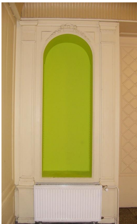
Obr. 46- Detail, Výklenek na sochařskou výzdobu ve vstupní hale, současný stav 2016.
