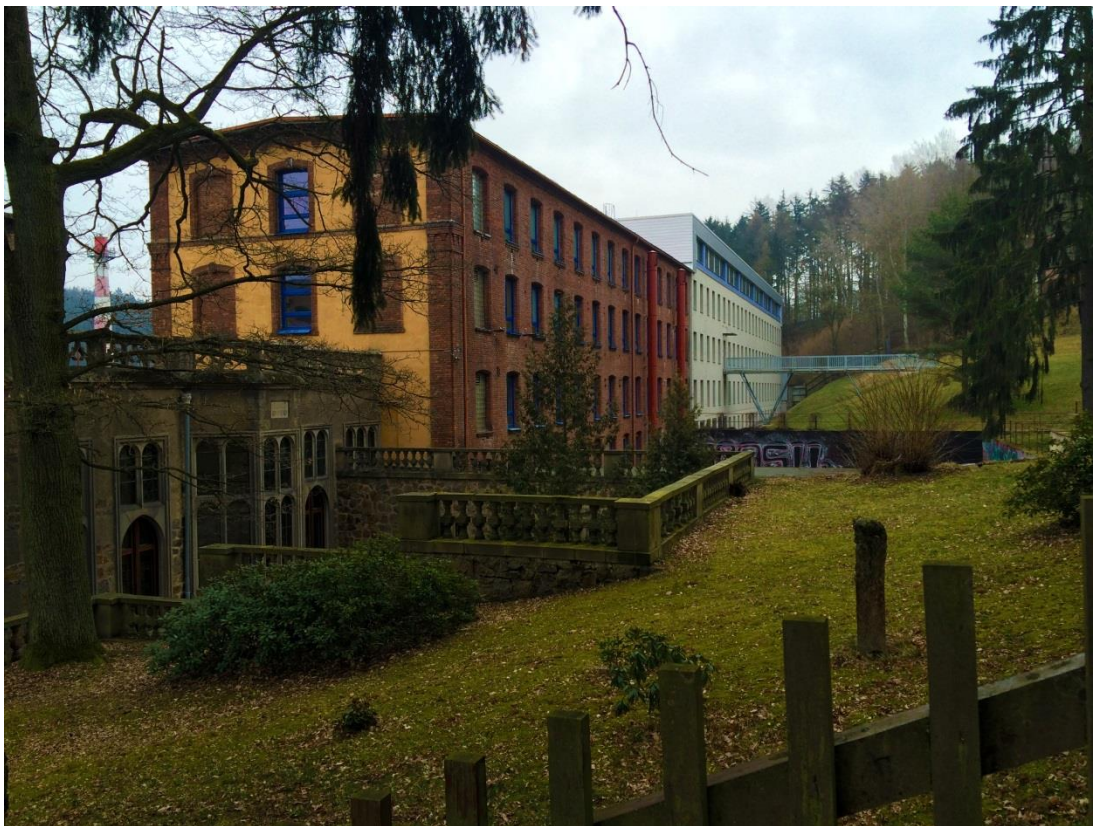
Obr. 56- Areál Střední uměleckoprůmyslové školy Jihlava-Helenín, na fotografii zleva je neogotické křídlo, vedle je budova bývalé tkalcovny a současná budova Střední školy stavební a depozitáře muzea Vysočiny, současný stav 2016.
