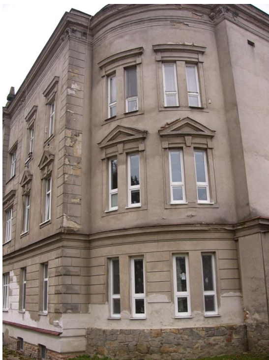
Obr. 22- Detail, bytový dům pro úředníky, současný stav 2016.
