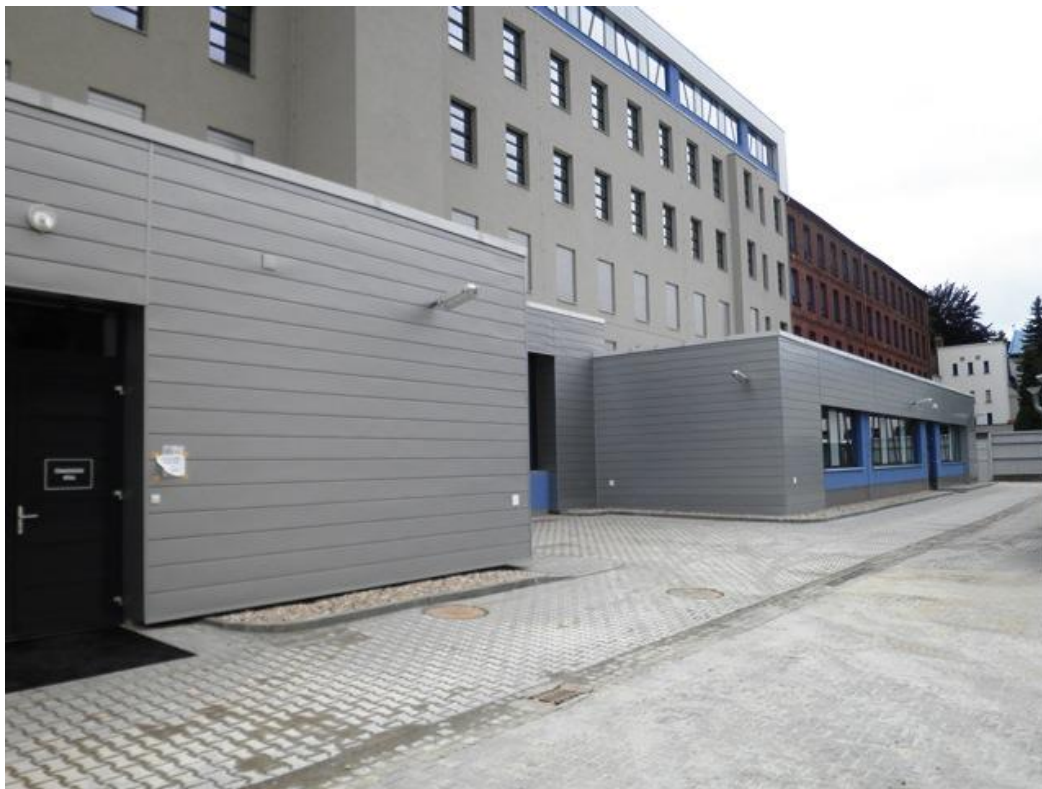
Obr. 58 - Rekonstrukce bývalé budovy tkalcovny, rok 2013.
