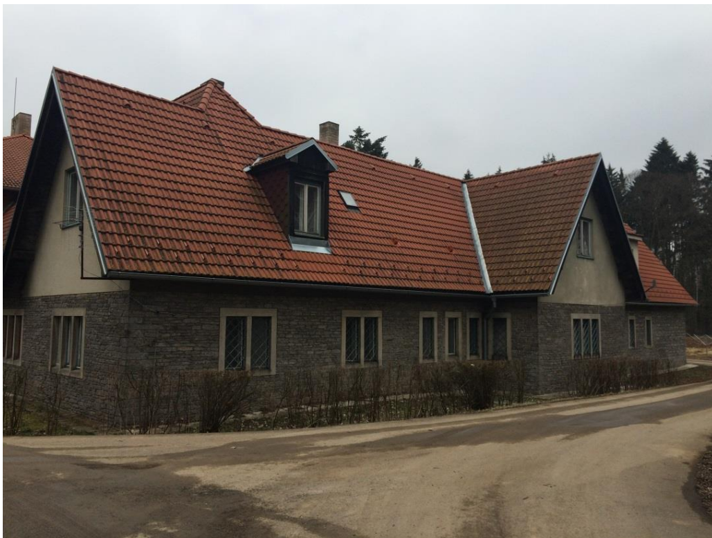
Obr. 8- stavba anglického domu v lesoparku v Henčově, současný stav 2016
