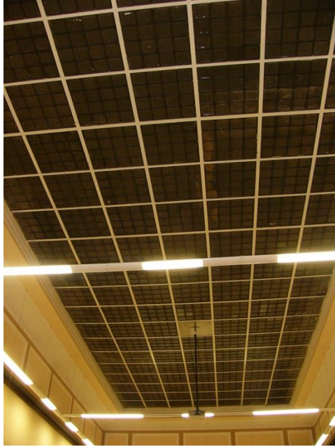
Obr. 52- Bývalý biograf, luxferový strop, současný stav 2016.
