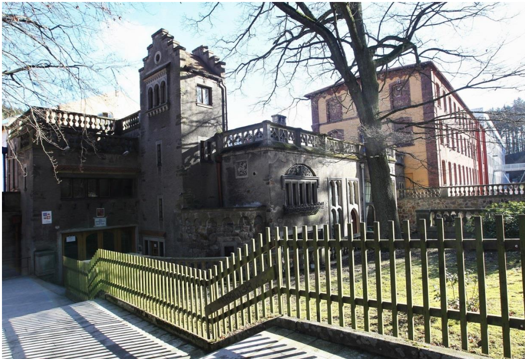
Obr. 28- Reprezentativní neogotické křídlo z roku 1919, vpravo bývalá budova tkalcovny, současný stav 2016.
