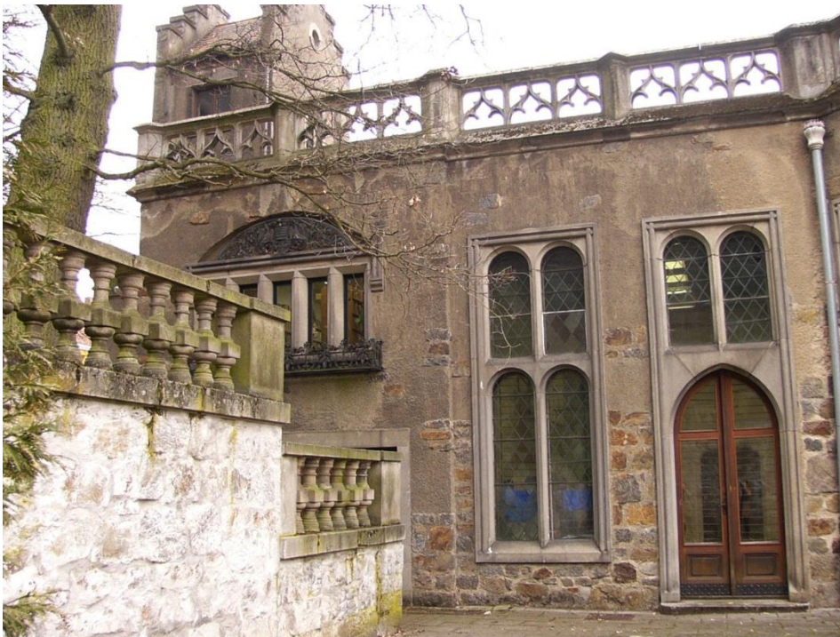
Obr. 31- Jižní fasáda reprezentativního neogotického křídla z roku 1919, současný stav 2016.
