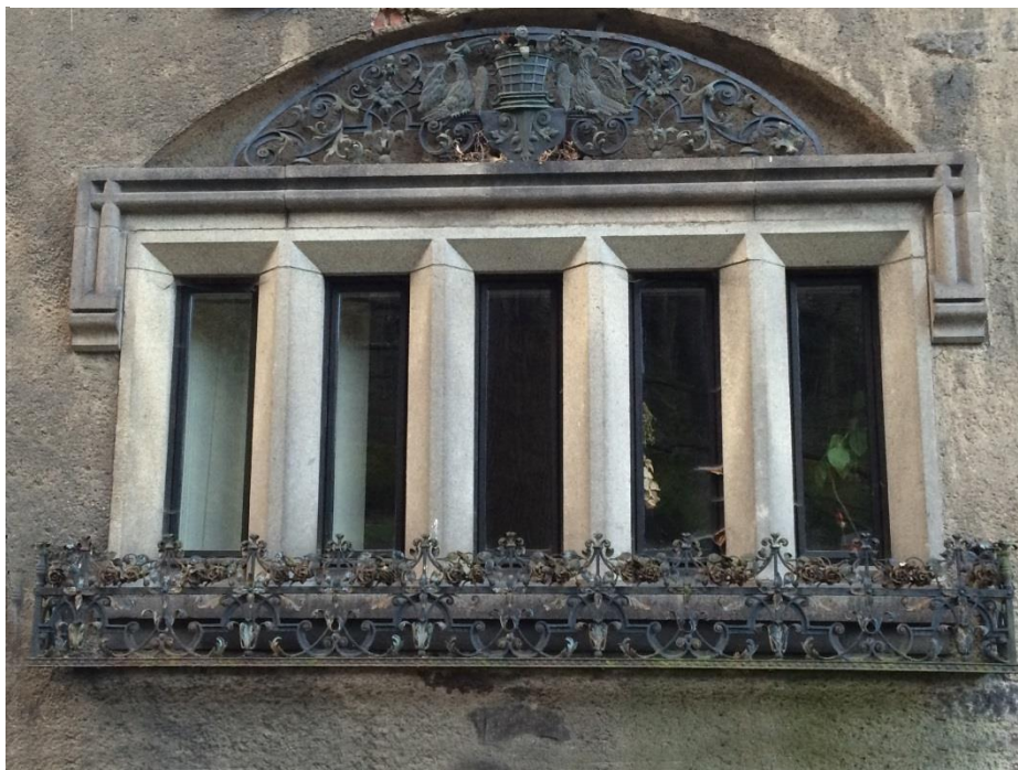
Obr. 33- Detail okna, jižní fasáda, současný stav 2016.
