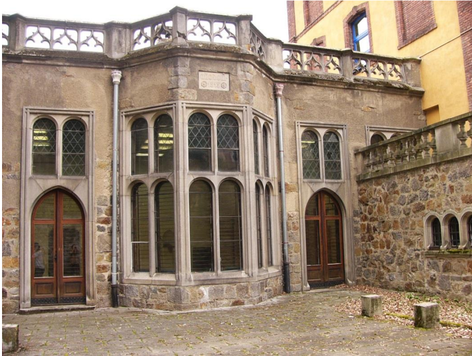
Obr. 32- Jižní fasáda reprezentativního neogotického křídla z roku 1919, současný stav 2016.
