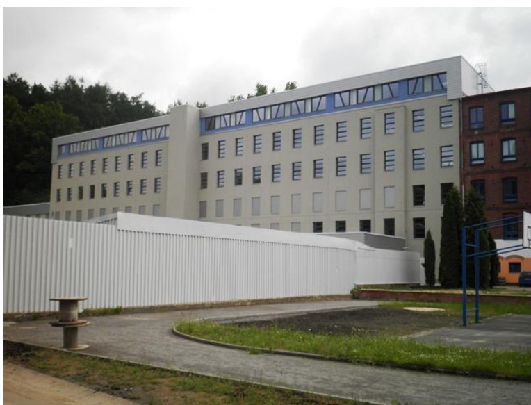
Obr. 57- Rekonstrukce bývalé budovy tkalcovny, rok 2013.
