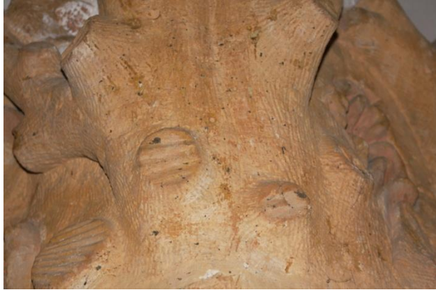
Obr. 10. Detail odseknutých větví
