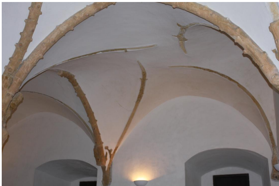
Obr. 49. Klenba Stromové síně
