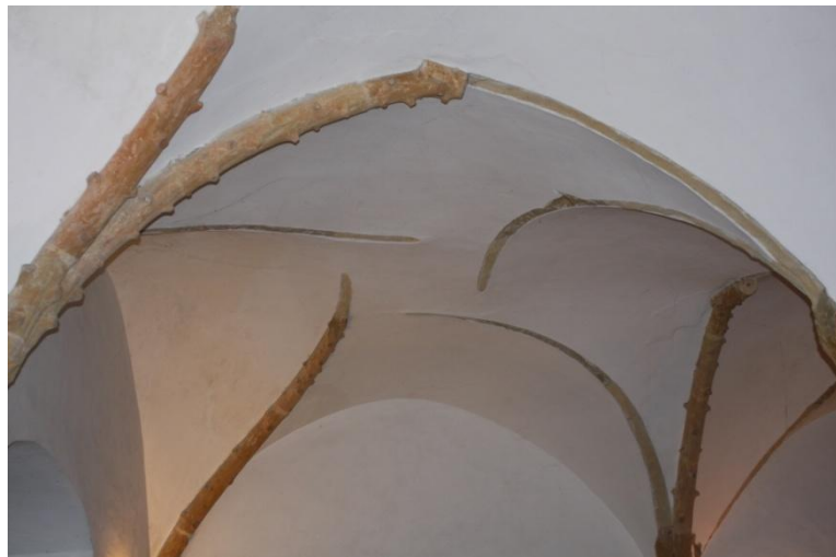
Obr. 12. Klenební žebra nedosahující do vrcholů jednotlivých polí
