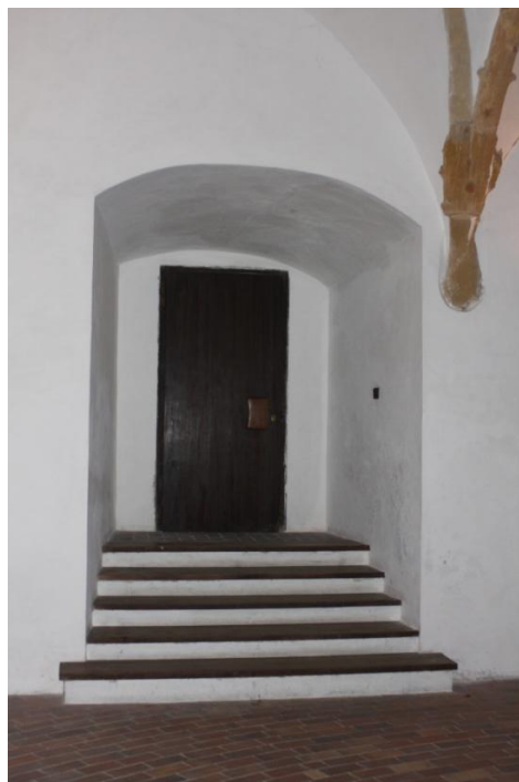
Obr. 16. Vchod v severní stěně
