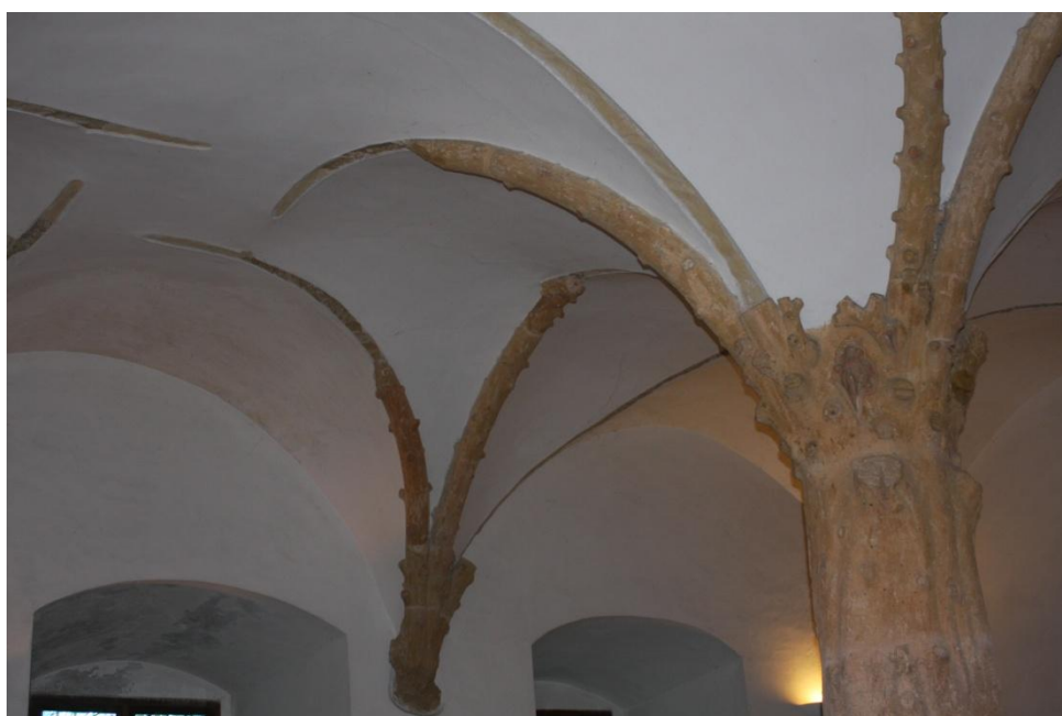
Obr. 50. Klenba Stromové síně
