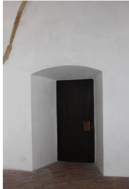
Obr. 18. Vchod v jižní stěně
