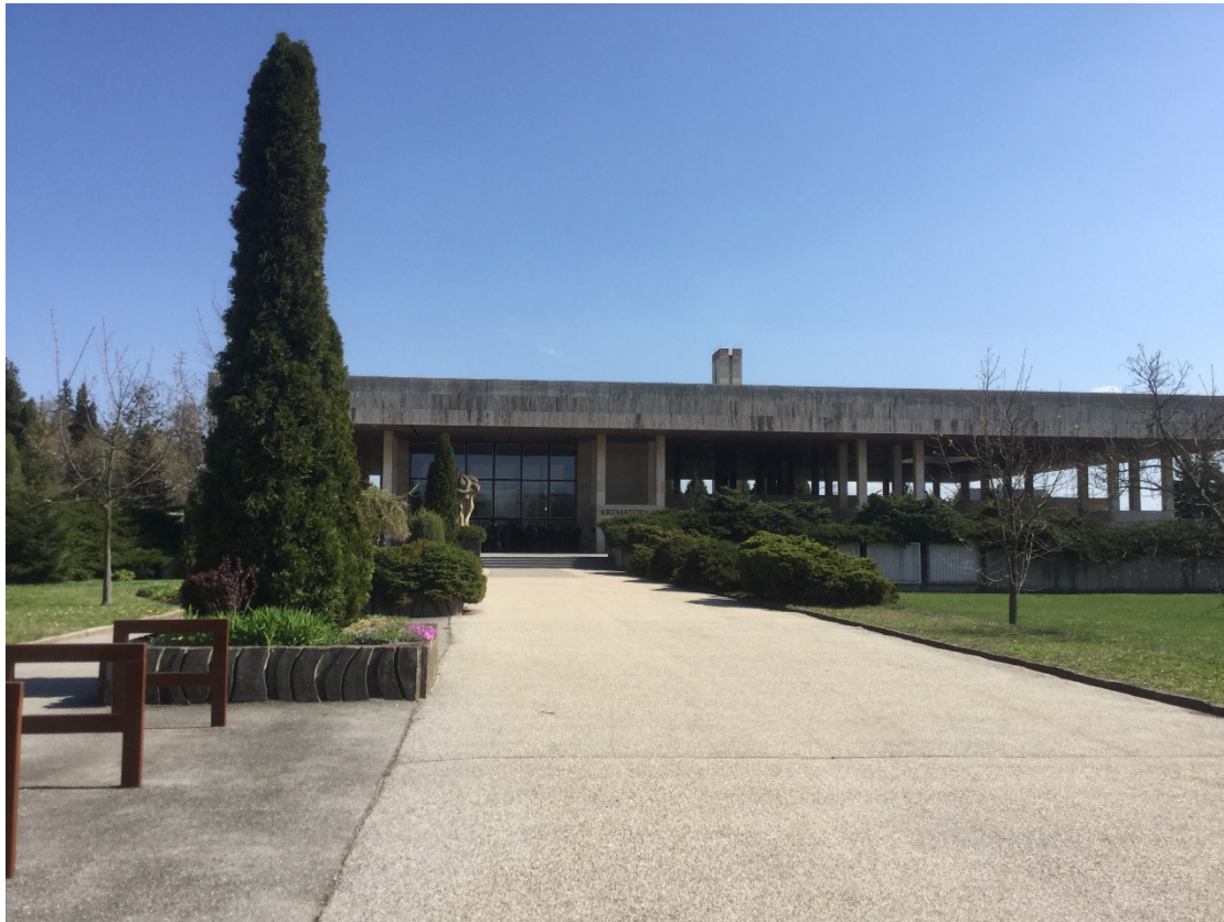
21. Příjezdová cesta ke krematoriu
