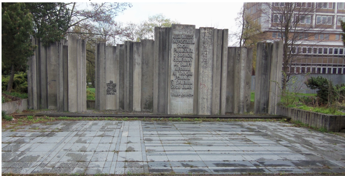
18. Detail delších betonových stěn
