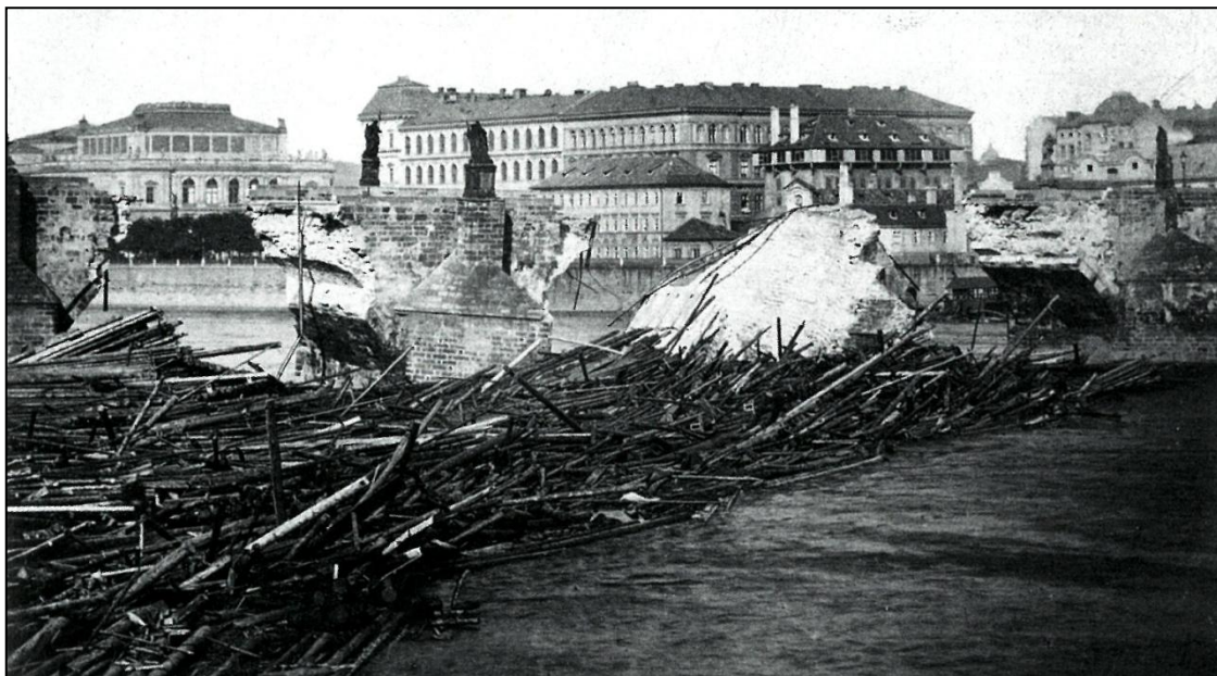
Obr. 47: Dobová fotografie Karlova mostu krátce po povodni 1890. Na snímku je možné vidět stržené mostní pilíře a oblouky. Obrázek převzat z Státníková 2012 .
