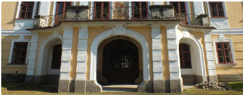
21 Portikus na severozápadním průčelí.
