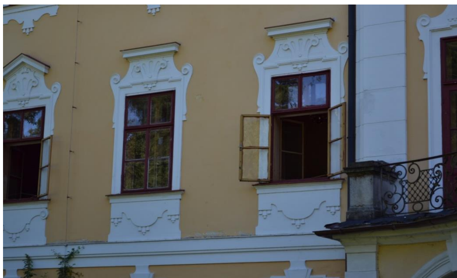
15 Typus piana nobile, okna zasazená v dekorované šambráně s variujícím typem okenní římsy.
