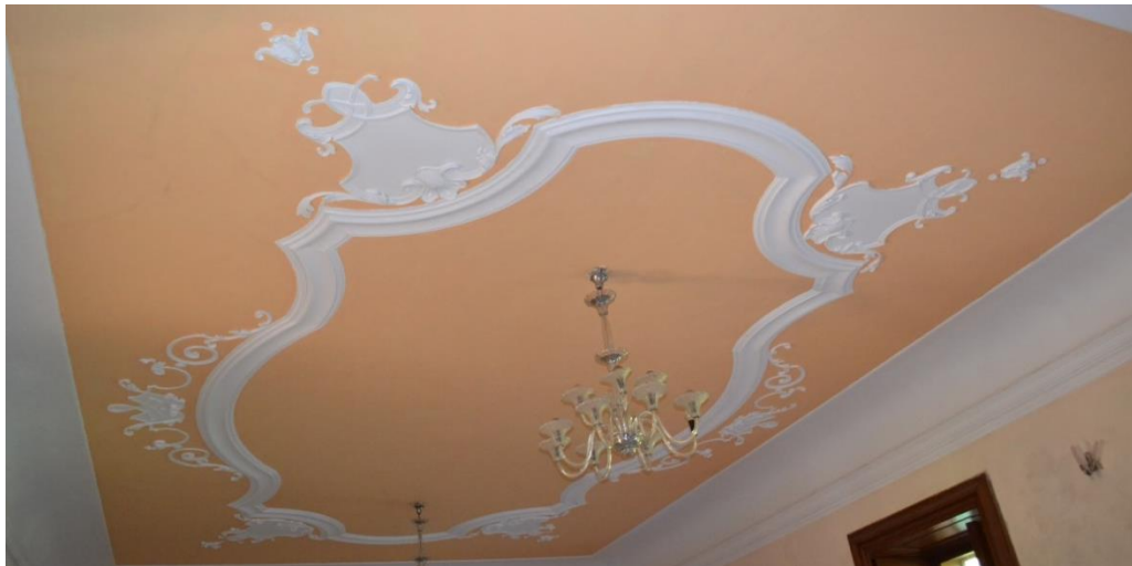
51 Štukově dekorovaný strop reprezentativního sálu. (a)
