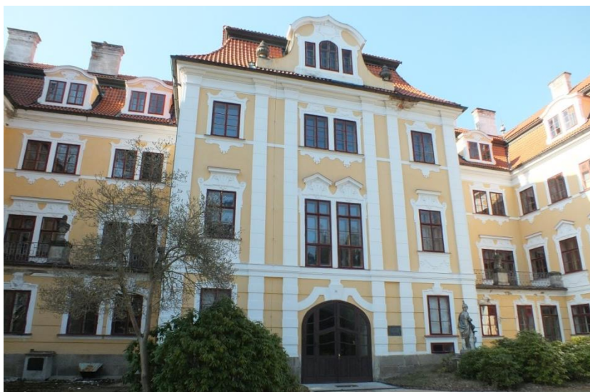
28 Středový rizalit jihovýchodního průčelí.
