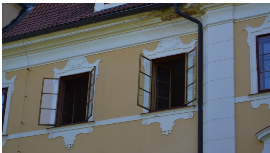
16 Typus druhého patra, okna zasazená v dekorované šambráně, parapetní římsa, korunní římsa.
