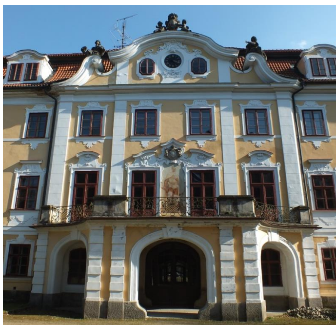
19 Středový mělký rizalit s portikem severozápadního průčelí.
