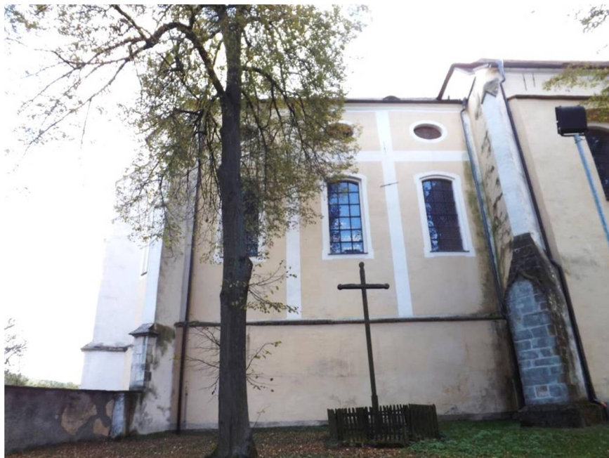
[11] Svatá Dobrotivá, pohled na presbytář konventního kostela od severu. Současný stav.
