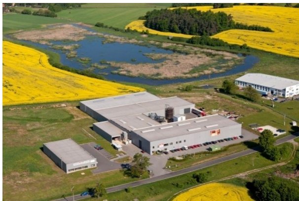
Příloha 1: Letecký pohled na ESCO
