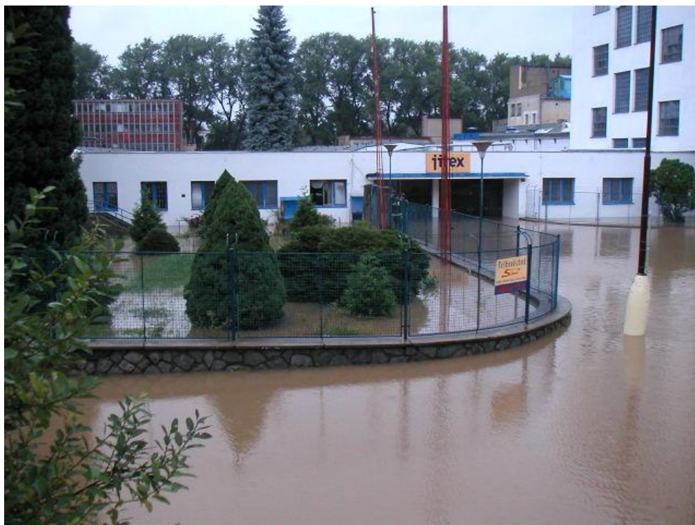
Příloha 2: Fotografie areálu firmy zasaženého povodní
