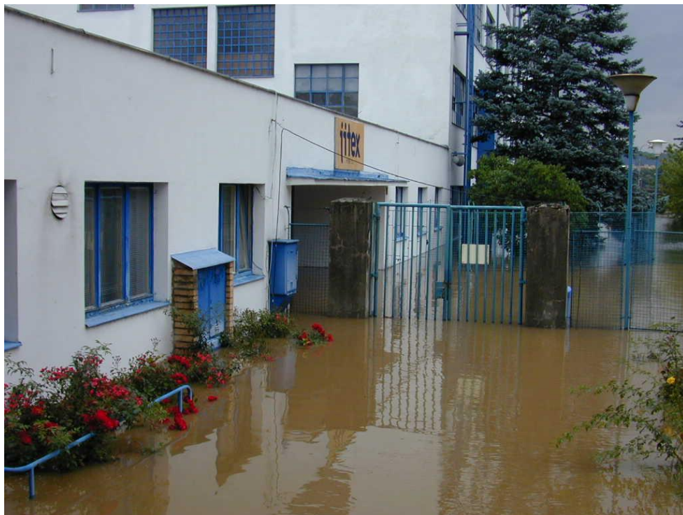
Obrázek 4 - Vstup do firmy zasažený povodní
