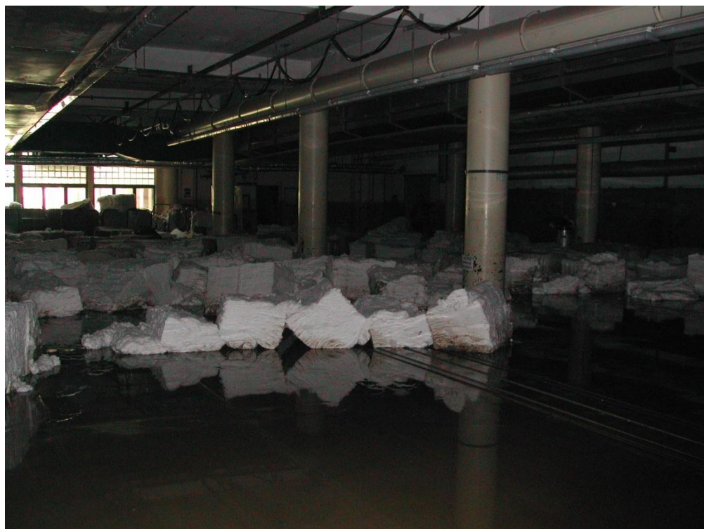
Příloha 1: Fotografie znázorňující zásoby zasažené povodní
