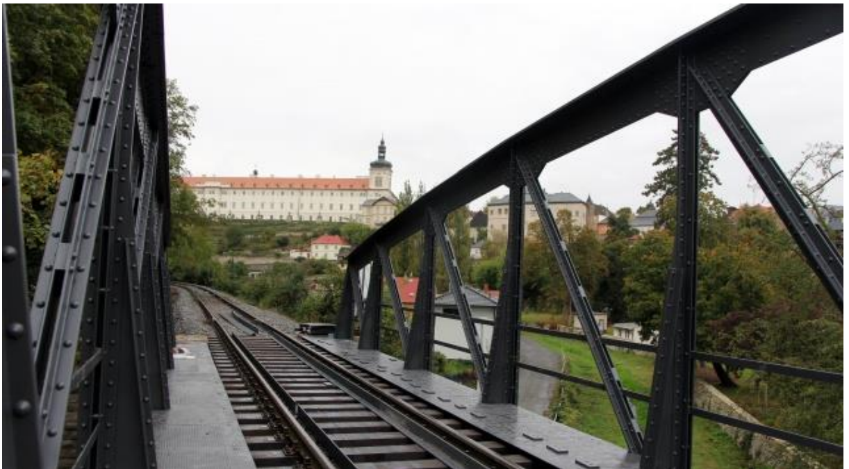
Obrázek 5 Ocelový most v Kutné Hoře
