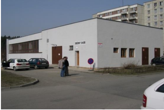
Obrázek 7: Sběrný dvůr Sídliště nad Lužnicí
