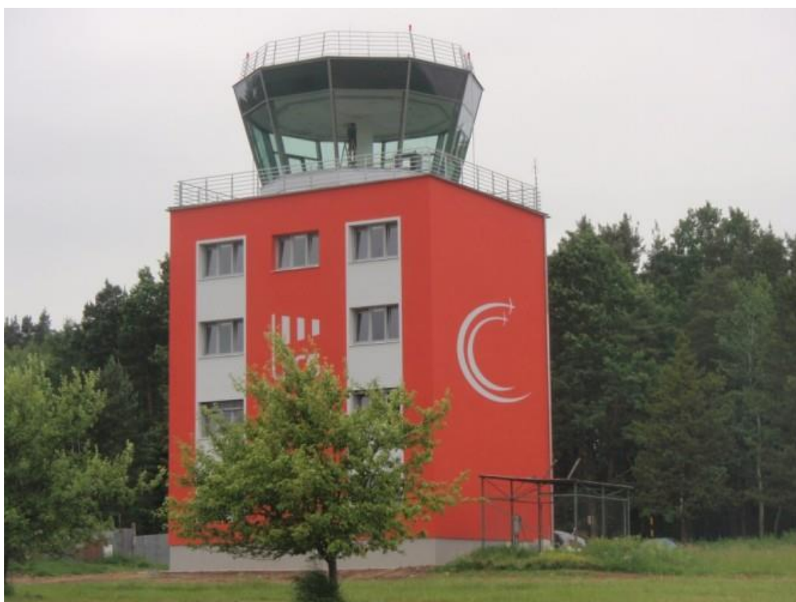
Obrázek 2 zrekonstruovaná řídicí věž-první etapa druhé fáze modernizace
