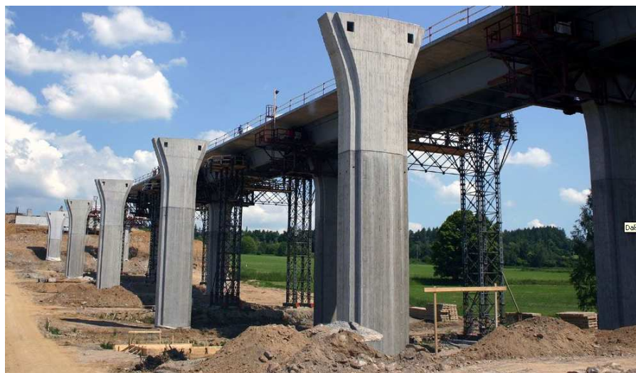
Obrázek č. 6: Fotografie ze stavby dálnice D3 45
