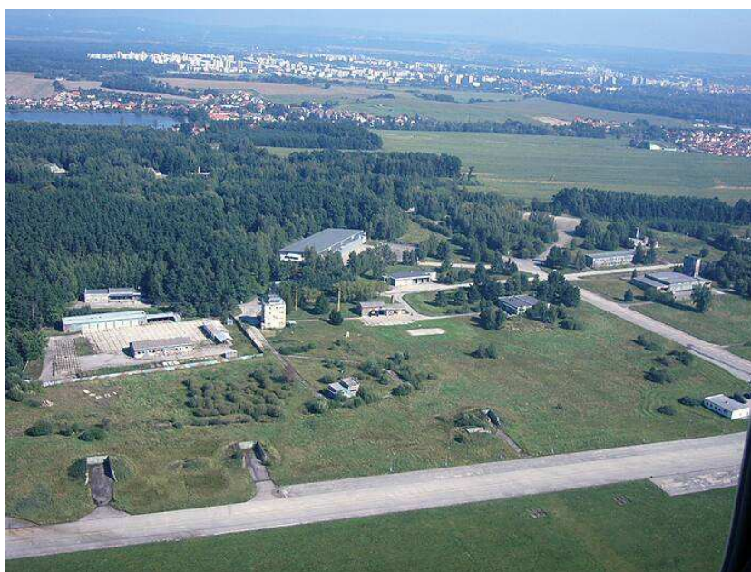
Obrázek č. 9: Letecký pohled na letištní řídicí věž, část pojízděcí dráhy a v pozadí sídliště Máj 48
