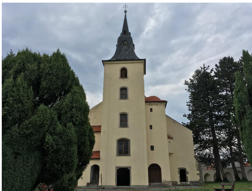
Obr. II/19 Hřbitovní kostel Nanebevzetí Panny Marie v Sušici dnes
