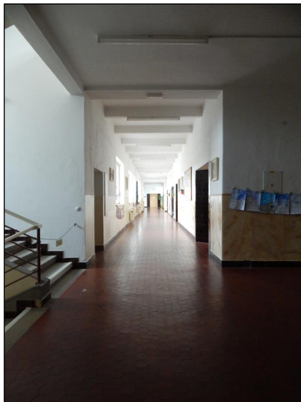
28. Pohled do chodby spojující schodiště
