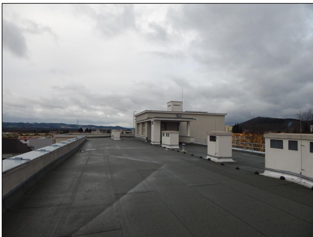
26. Střecha – pohled na bývalé sprchy
