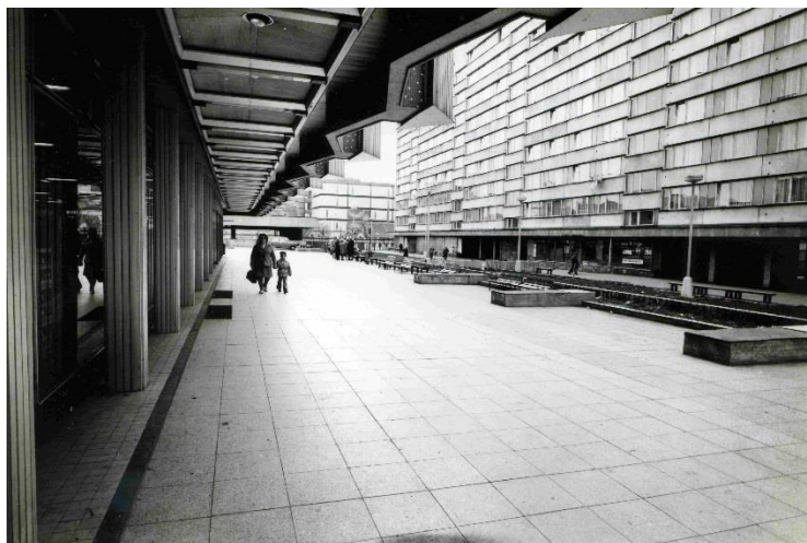
77/ OD Družba po rekonstrukci, současný stav. Foto: autorka.
