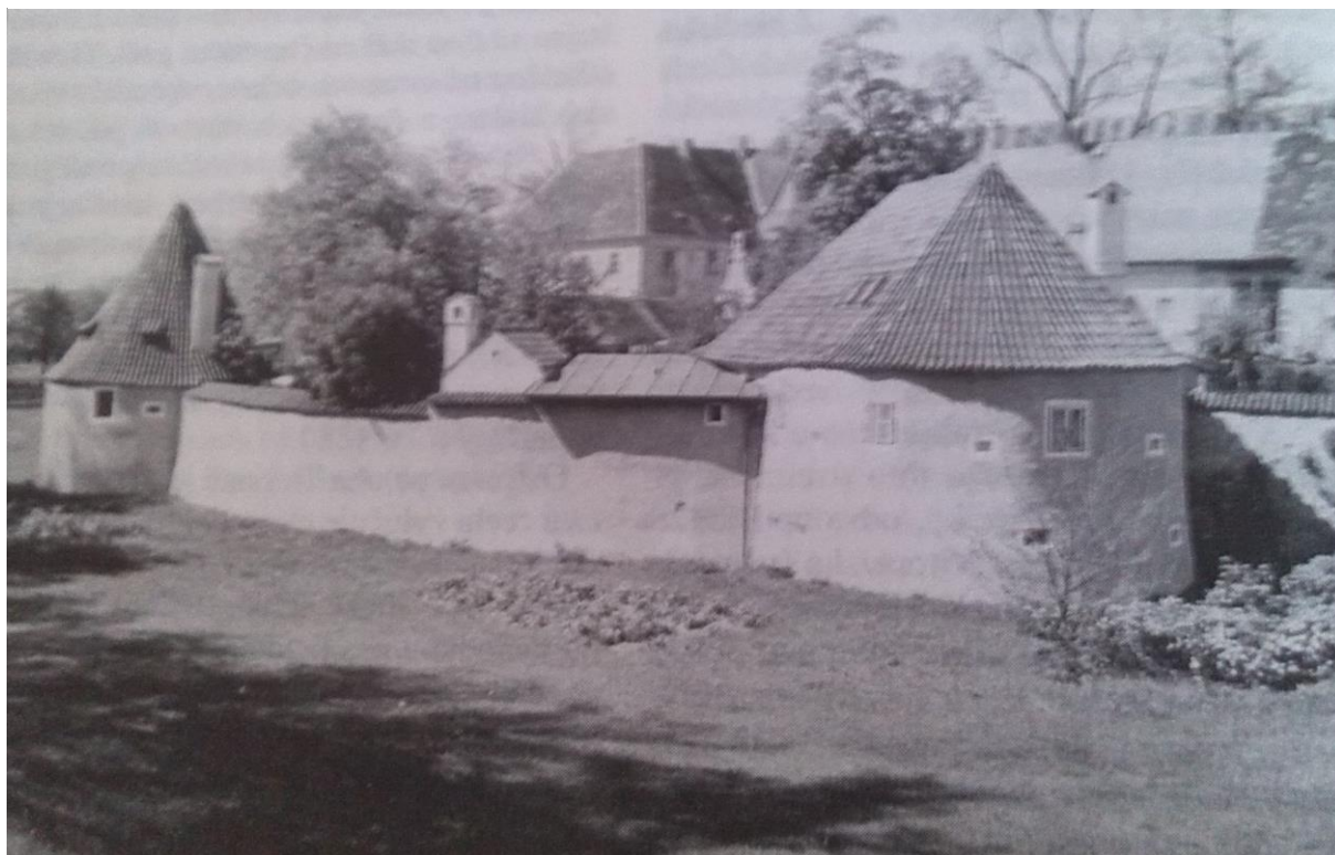
Příloha 19: opevnění jihozápadní nároží města s baštami čp. 119 a 120, 1980
