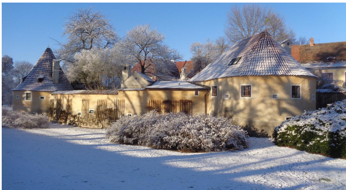
Příloha 20: opevnění jihozápadní nároží města s baštami čp. 119 a 120, 2017 1. 1.
