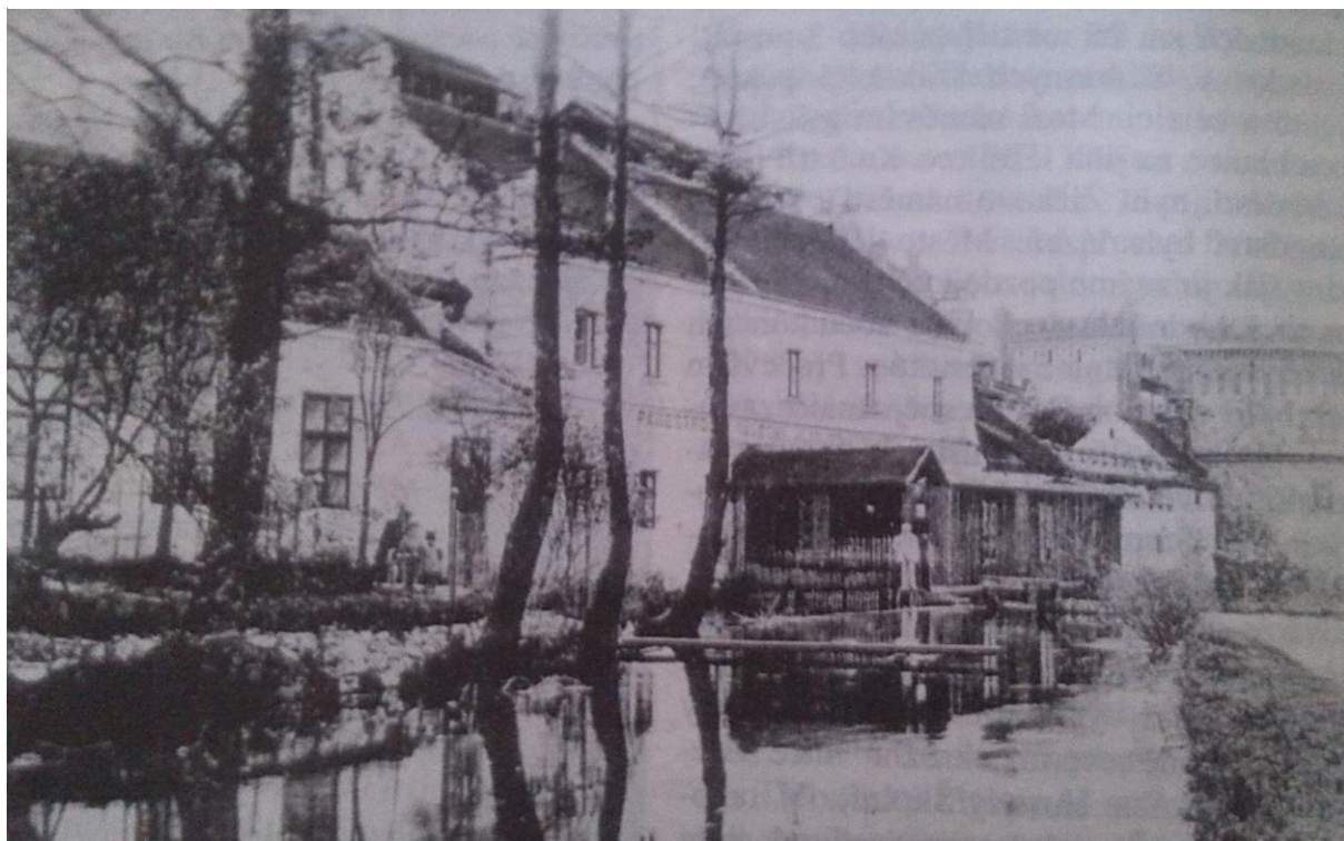
Příloha 17: mlýn čp. 222/11, bašta jihovýchodního nároží městského opevnění, před rokem 1905
