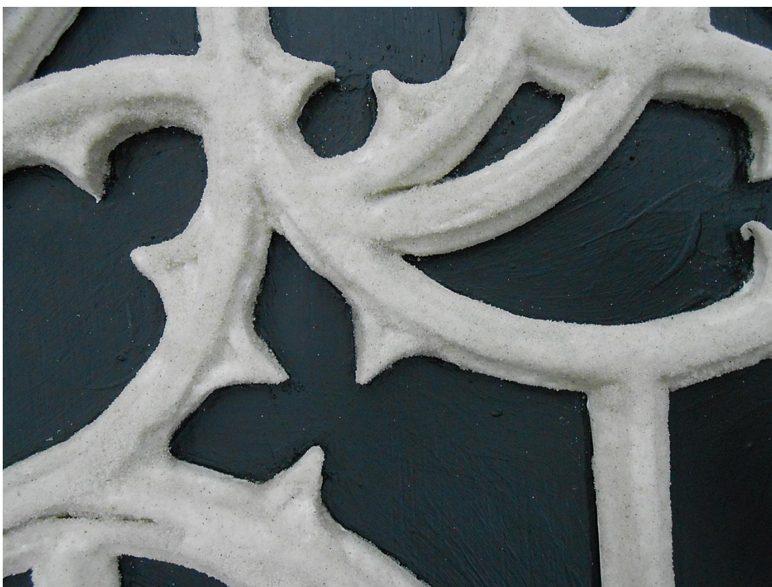
Obr. 11: Detail kružby s imitací pískovce
