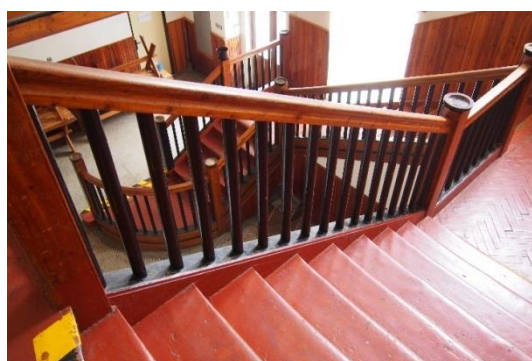
Obr. 10: Původní točité schodiště na zámku
