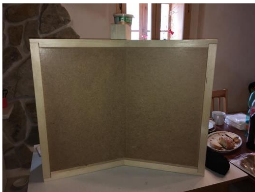
Obr. 10 – 11: Osazení konstrukce sololitovou deskou
