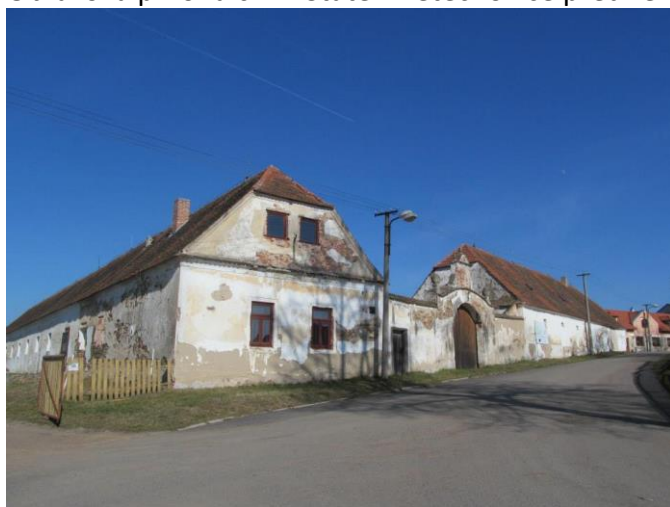
Obrazová příloha č.2 – Statek Netěchovice před rekonstrukcí
