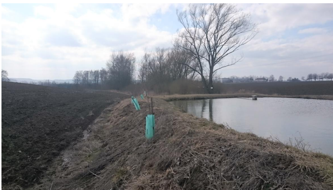
Obr. 16. Současný pohled na bariéru proti erozi u rybníku Olšovec
