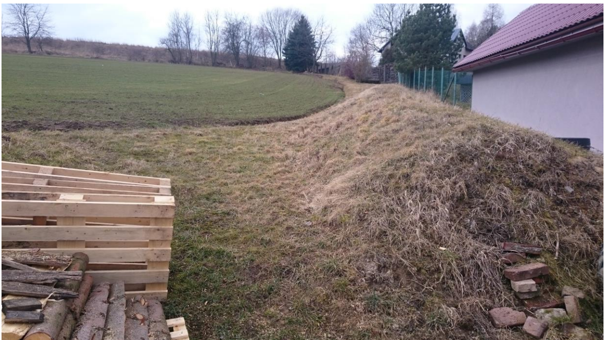
Obr. 23. Vybudovaný ochranný val nad obcí Poříčí
