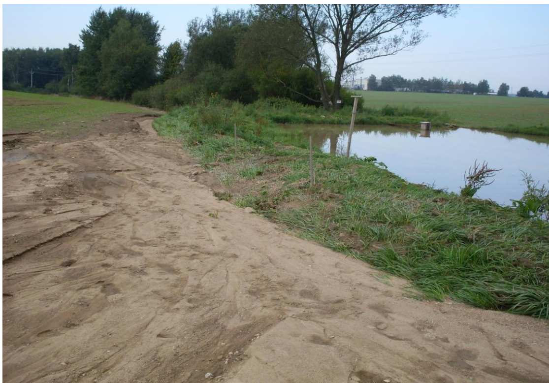
Obr. 15. Kumulace erozního materiálu u rybníku Olšovec
