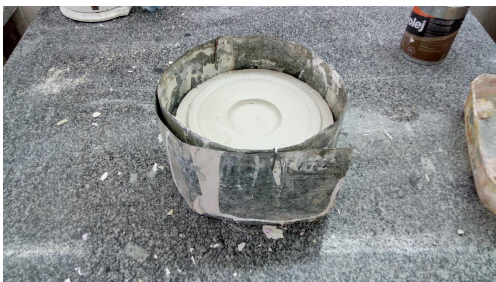
Obr.29 – fotodokumentace praktické realizace
