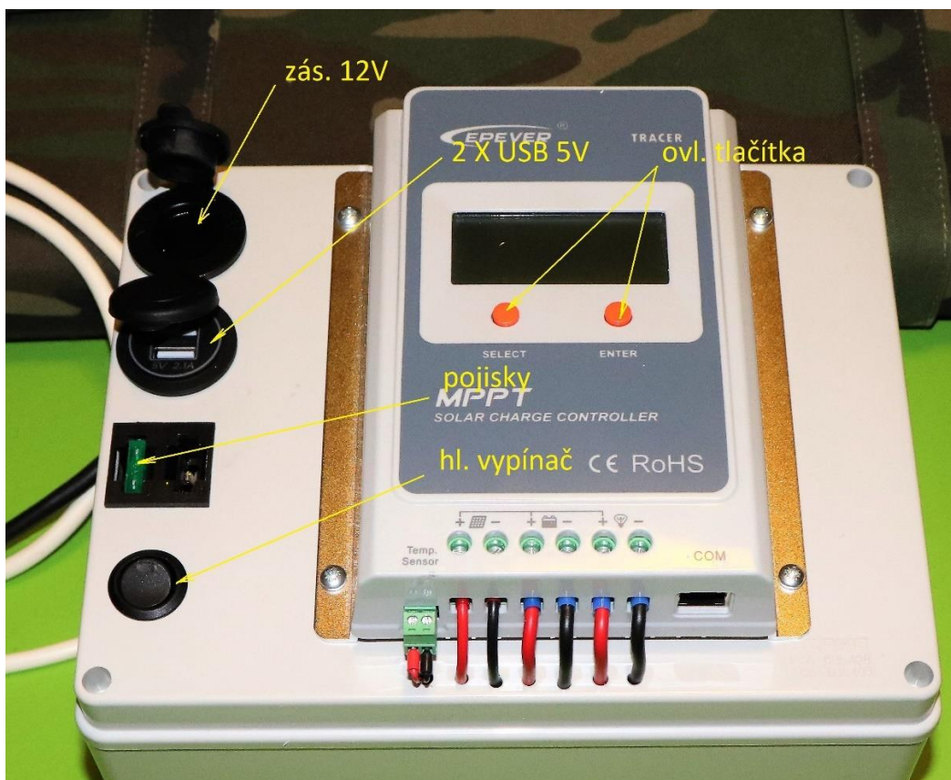
Obrázek 3.5: Zhotovený systém, foto autor.
