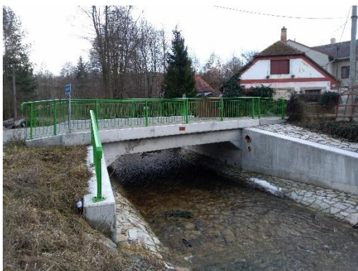
Fotografie č. 49: Most v obci Škúdra-samoty; zdroj: vlastní fotodokumentace
