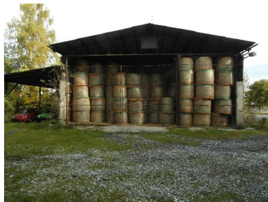
Fotografie č. 46: Skladovací hala; zdroj: vlastní fotodokumentace
