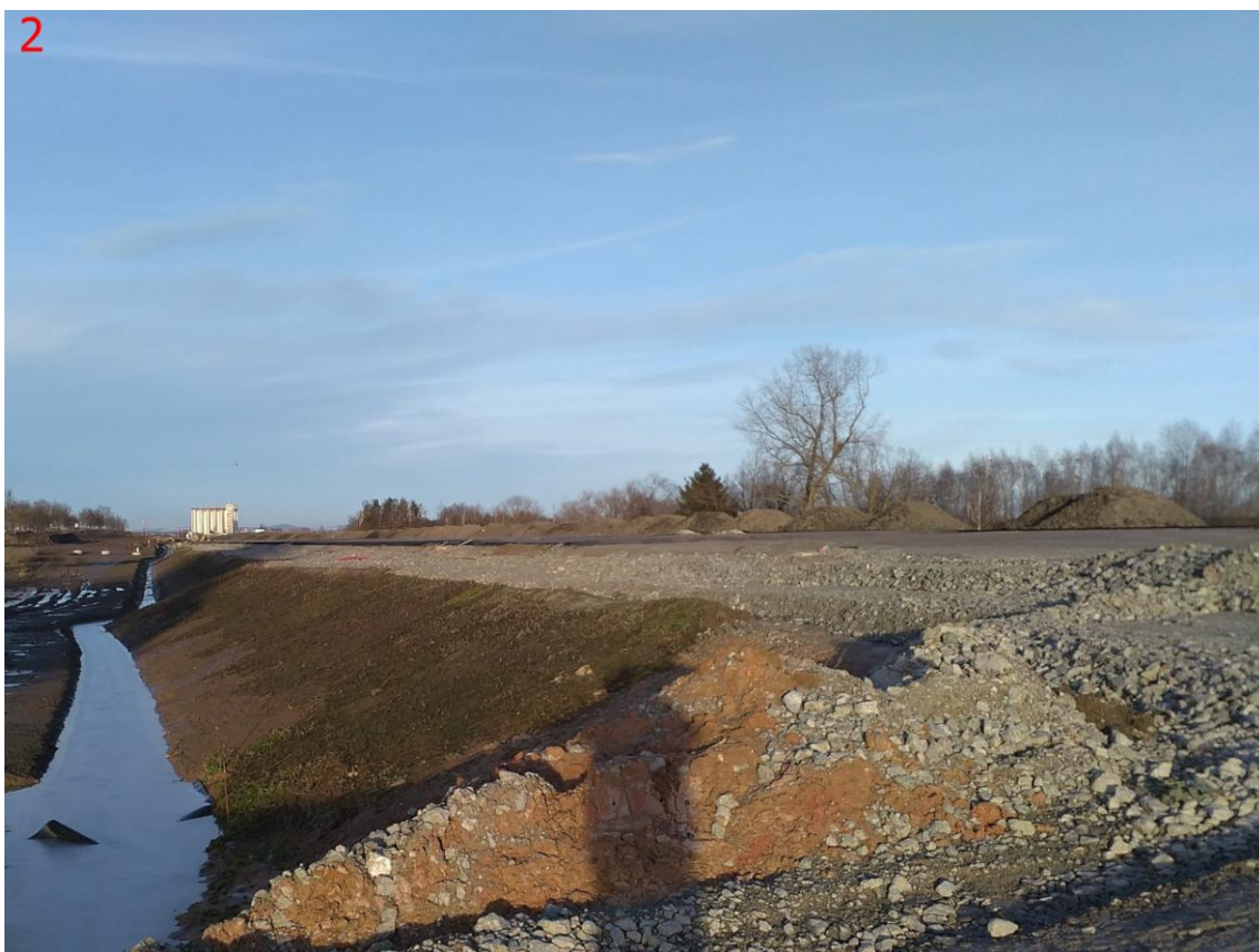
Obrázek č. 2 – Fotbalové hřiště při výstavbě dálnice D3 u obce Neplachov (rok 2018), Zdroj: Autor (24. 1. 2018)
