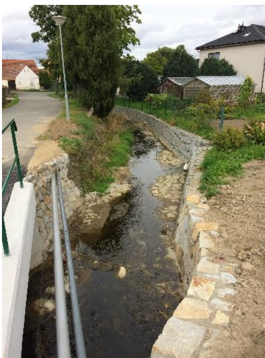
Opevněné koryto v intravilánu obce
