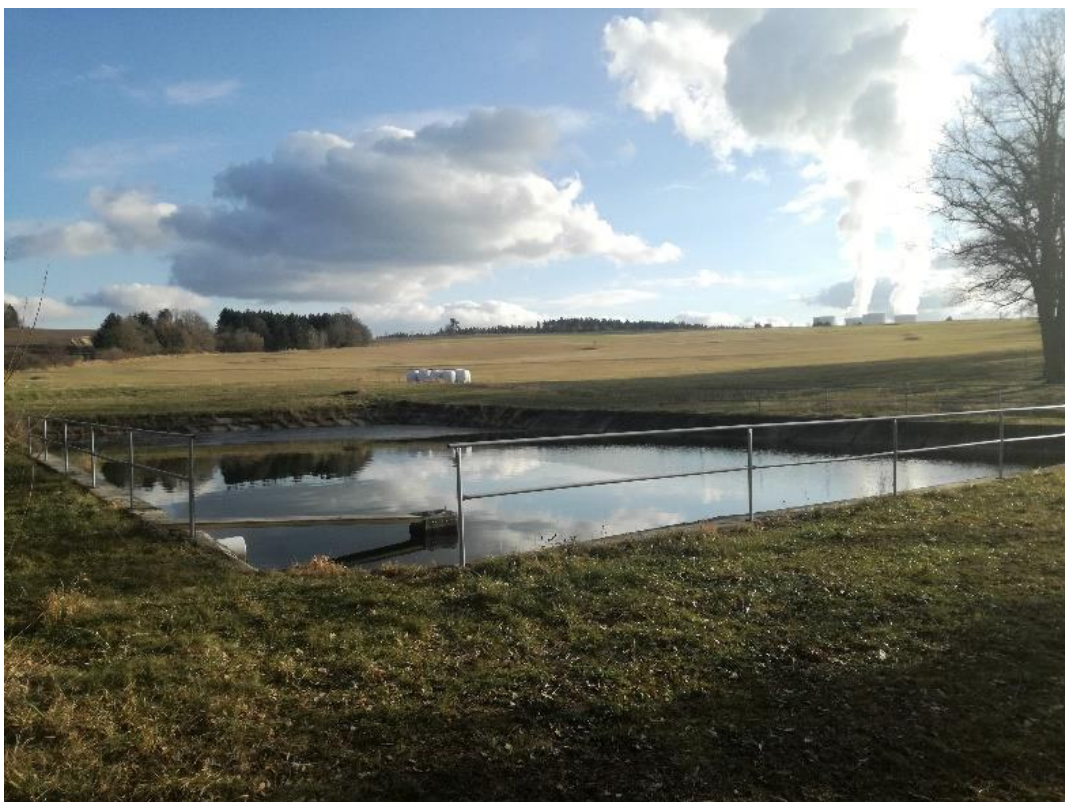
VP4 – protipožární nádrž
