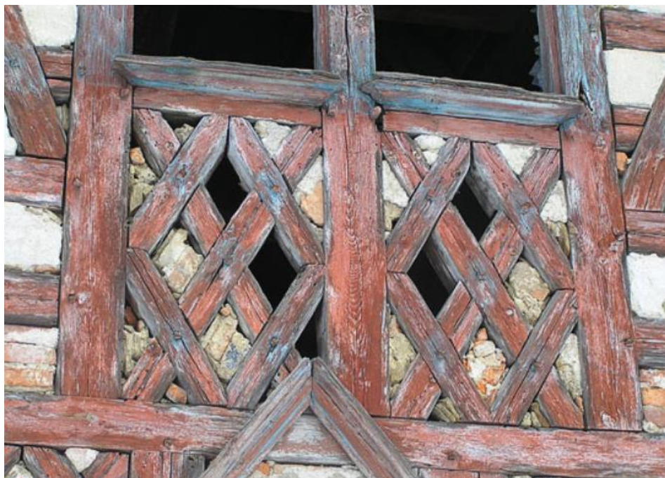
Obr. č. 16 Konstrukce hrázdění s cihelnými výplety ve štítě patrového domu. Vedle statické funkce plní hrázdění rovněž funkci dekorativní. Obec Salajna, okres Cheb. (Zdroj: Lidová architektura).
