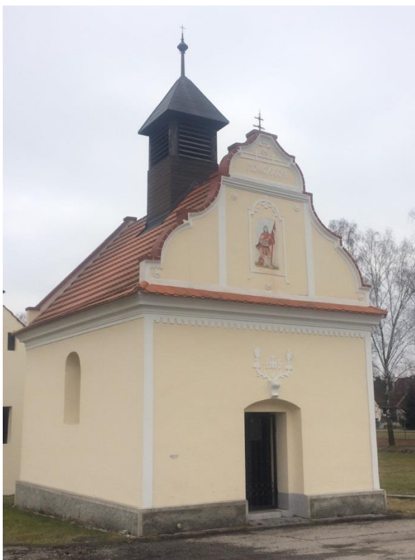
Obr. č. 28 - Návesní kaple sv. Floriána (Zdroj: autor)
