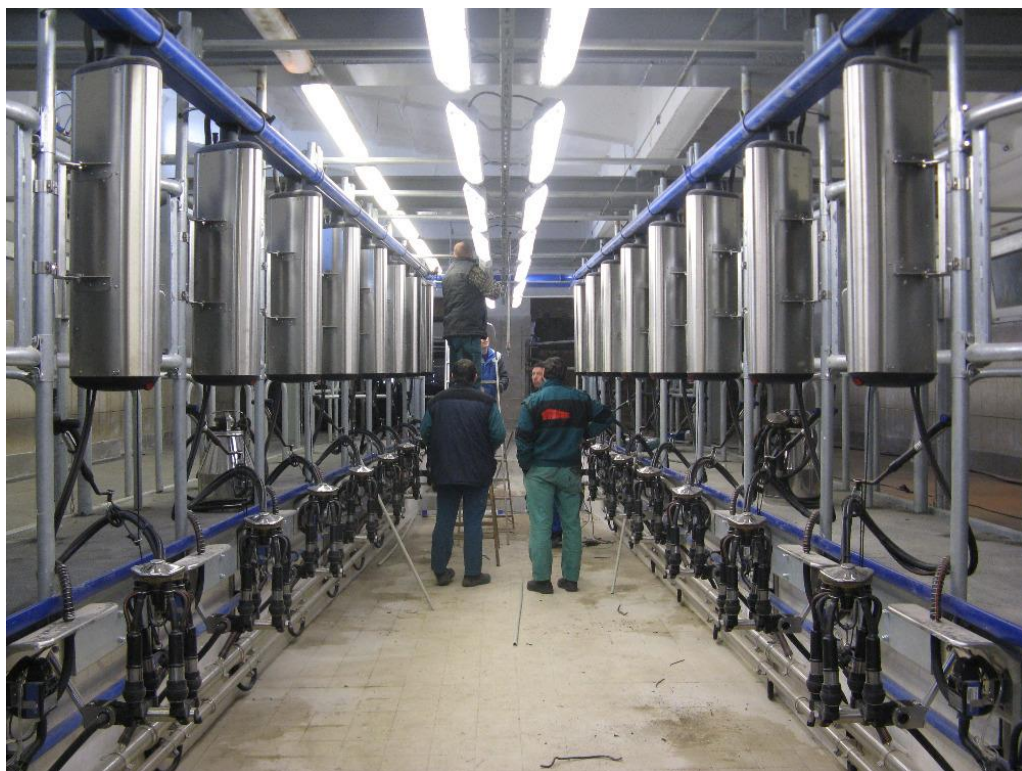
Obr. č. 5 – Stavba nové dojírny od firmy Delaval (foto: A. Staňková, 2016)
