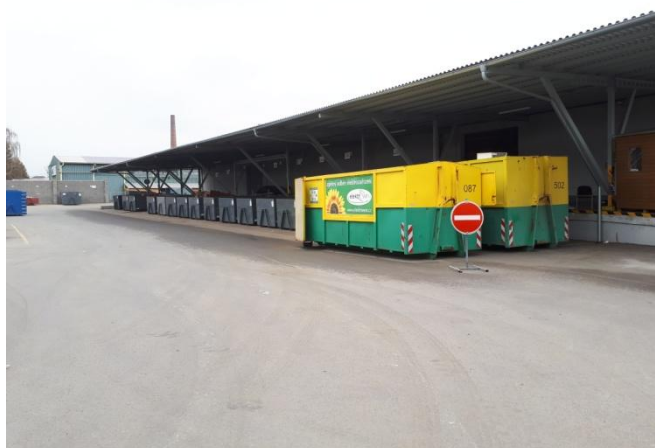
Obrázek 27: Fotografie č. 17 - Sběrný dvůr COH Klatovy - severní pohled
