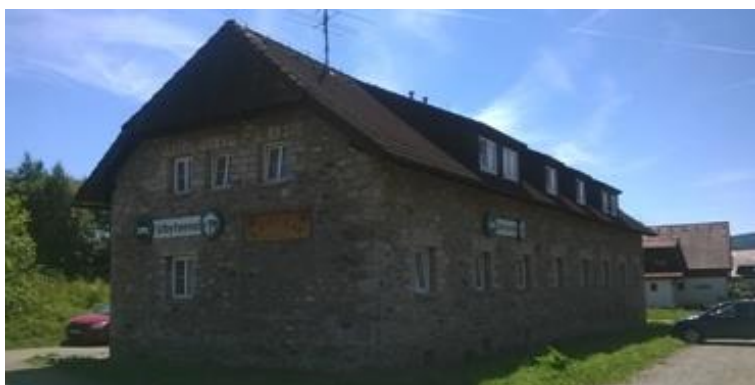
Obrázek 94: Dům č. p. 26; ubytovna Kameňák
