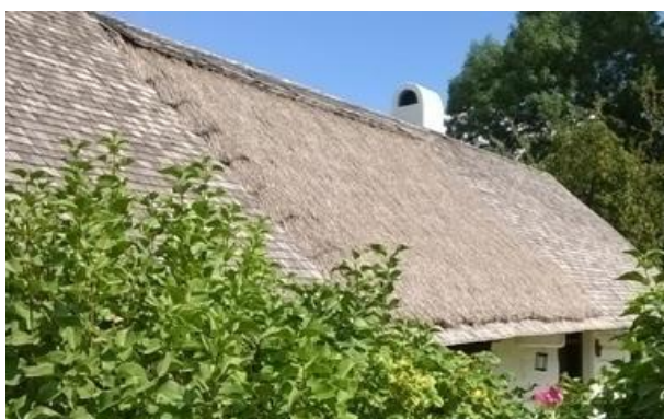
Obrázek 108; 109: Detail střechy domu č. p. 4 a rohu štítu
