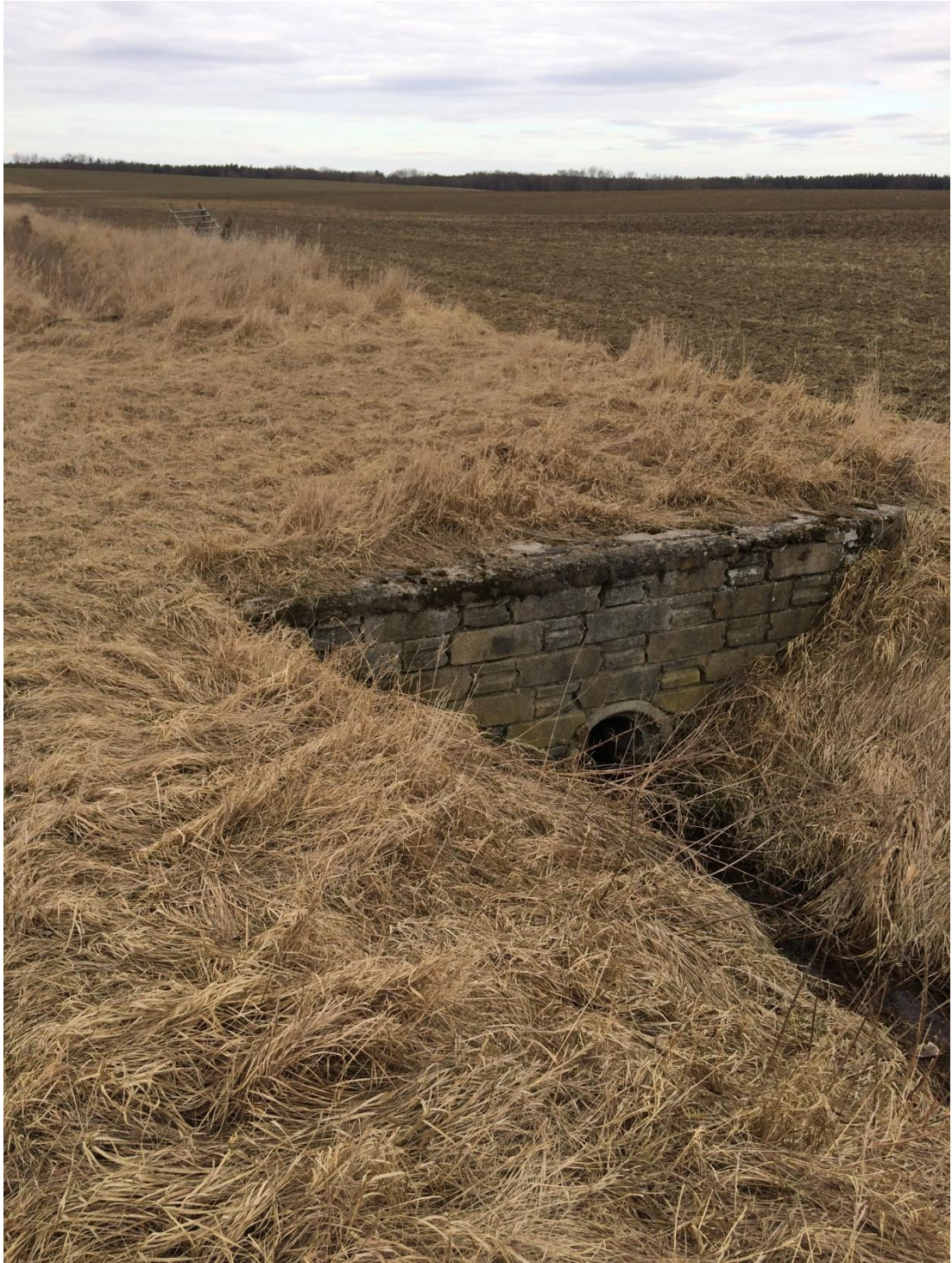
Příloha č. 6 Mostek spojující k.ú. Horní Slovénice a Dunajovice
