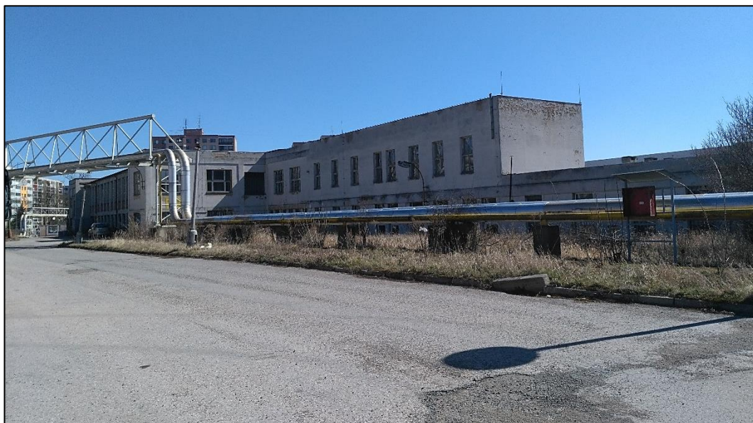
Obrázek č. 13 – Část doposud nezbourané budovy textilního závodu
