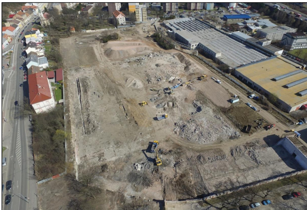
Obrázek č. 11 – Letecký snímek areálu při dokončování procesu demolice
