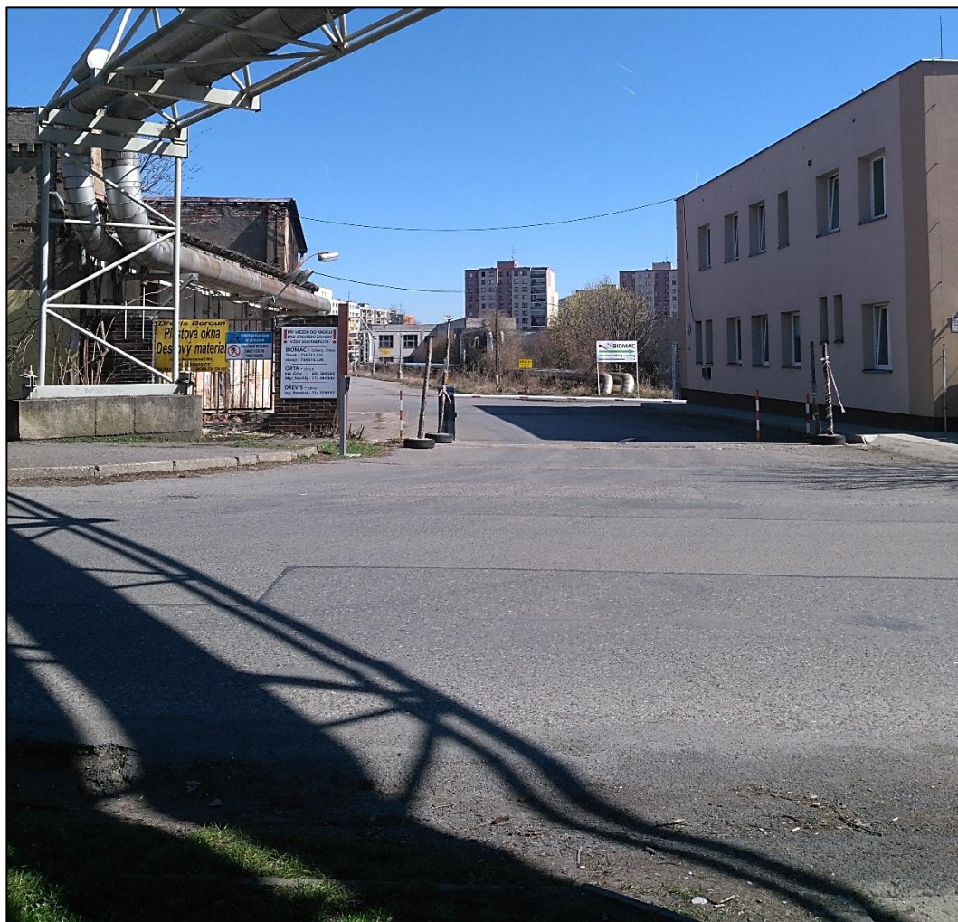
Vjezd do areálu brownfieldu z ulice Na Dražkách
