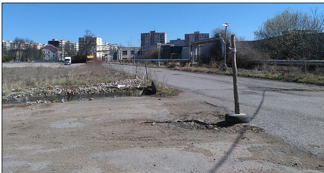
Komunikace protínající areál Z-V směrem, která vede podél dosud nestržené budovy bývalého textilního závodu – nízké tkalcovny
