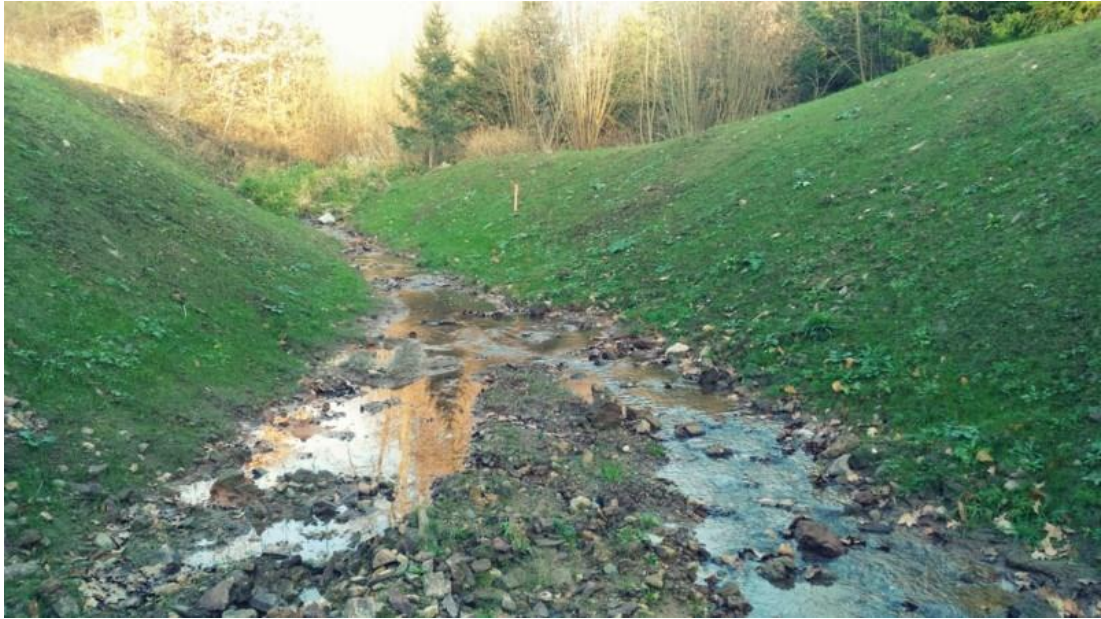
Příloha č. 6: Revitalizované koryto pod dálnicí D3
